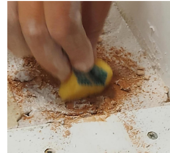
εφαρμογή χρώματος μέσα σε υπόστρωμα σοβά
