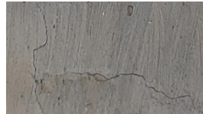
Ρωγμές πρώτου στεγνώσει & αφού σε δεξιά πλευρά (B)
