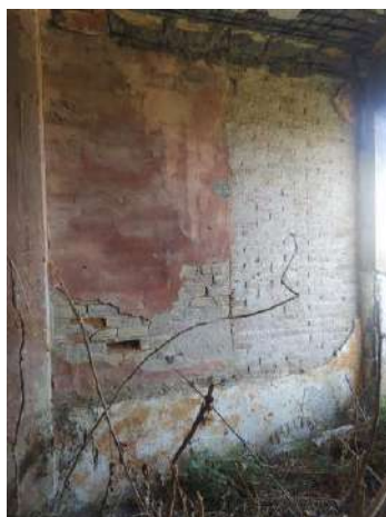
Εικ.54,55. Τοίχοι πλήρωσης υπογείου από πλινθοδομή
