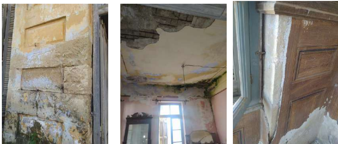
Εικ.49,50,51. Φέροντες τοίχοι από λιθοδομή και πλάκα σπλισμένου σκυροδέματος
