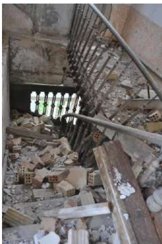
εικ.111,112. Δομικά υλικά τοίχου που κατέρρευσε
