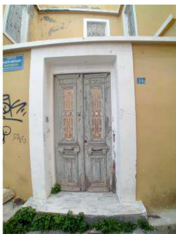
ξύλινη ταμπλαδωτή θύρα εισόδου- προσωπική λήψη
