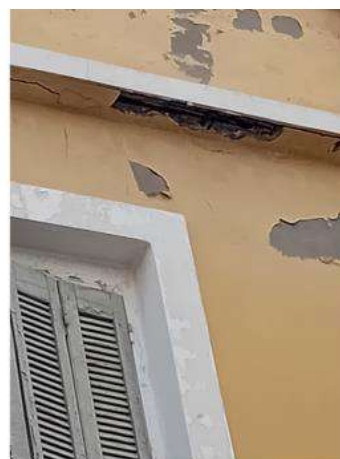
φθορά στο γείσο – ενανθράκωση σκυροδέματος και οξείδωση σιδηρού οπλισμού
