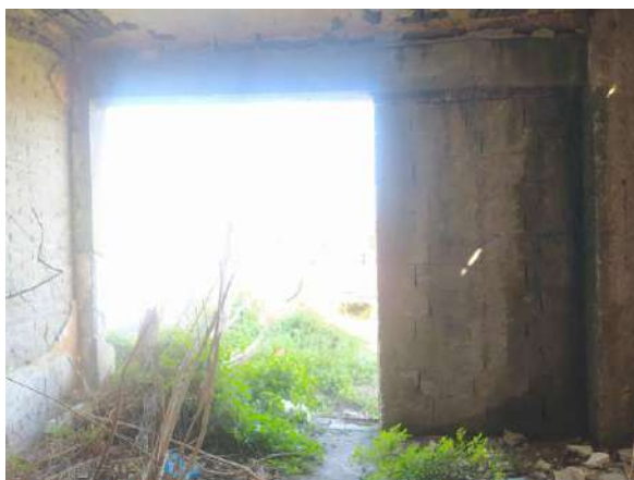
Εικ.53. Τοίχοι υπογείου από τσιμεντολιθοδομή
