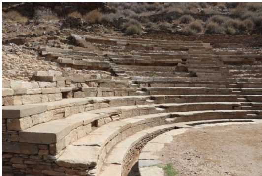
Εικ. 179: Τμήμα του κοίλου του θεάτρου Καρθαίας με τεχνητό λίθο για συμπληρώματα εδωλίων (αρχείο Κλ. Ασλανίδη)
