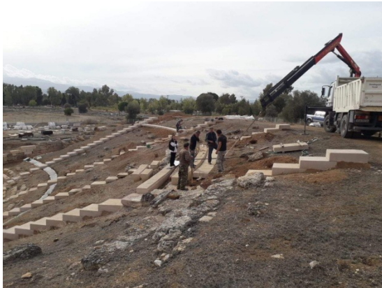
Εικ. 71: Εργασίες τοποθέτησης βαθμίδων (2022) (Κ. Μπουκάρας, όπως παρατίθεται στο https://diazoma.gr/theaters/αρχαίο-θέατρο-ερέτριας/ καρτέλα Πολυμέσα)
