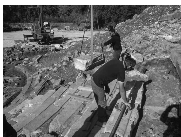
Εικ. 32: Επανατοποθέτηση συντηρημένων εδωλίων και υποποδίων στην κερκίδα III (Πλιάκου κ.ά. 2015, 390)
