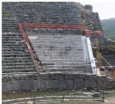
Εικ. 183: Κατασκευή κλίμακας παράλληλα με την αποκατάσταση της ακραίας ανατολικής κερκίδας στο θέατρο Δωδώνης ( https://diazoma.gr/theaters/archaio-theatro-dwdwnis/ )
