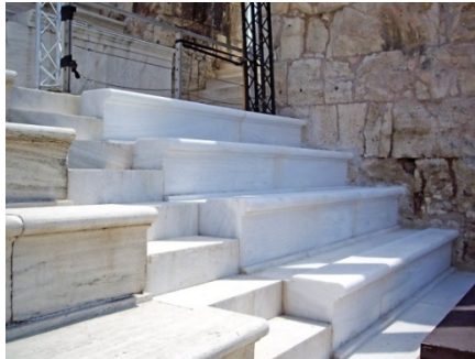
Εικ. 112: Ανατολική πάροδος μετά τη συμπλήρωση των τριών ανωτέρων σειρών εδωλίων (Πώς έγινε η Αναστήλωση, του Ωδείου Ηρώδου του Αττικού)
