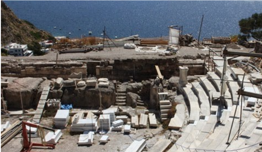
Εικ. 153: Άποψη των δυο πρώτων δυτικών κερκίδων, οι οποίες έχουν αποκατασταθεί και συντηρηθεί. Η μεταξύ τους κλίμακα έχει ανακατασκευαστεί με νέο μάρμαρο ( http://anaskafi.blogspot.com/2014/09/blog-post_12.html )
