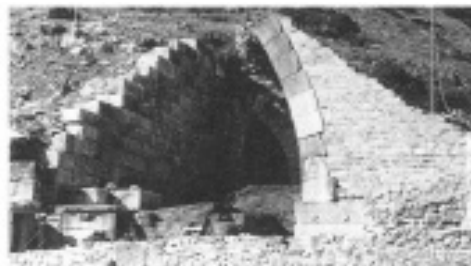
Εικ. 19: Το μεγάλο τόξο αντιστήριξης, ο αναλημματικός τοίχος και το μικρό τόξο αντιστήριξης (ό.π.)
