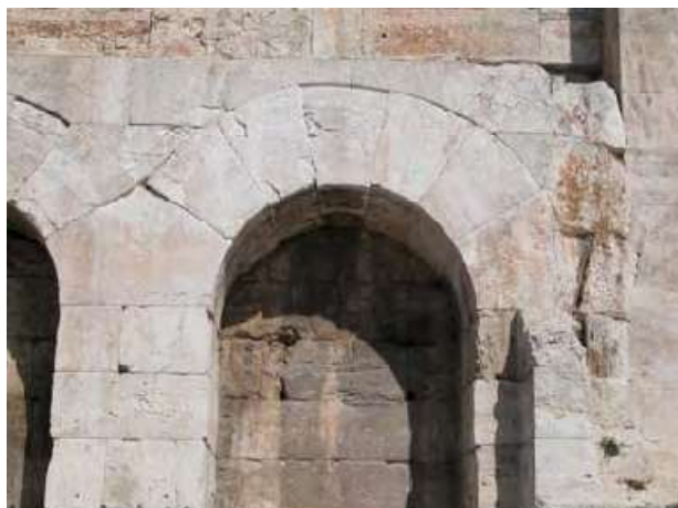
Εικ. 106: Το ανατολικό τόξο του νότιου τοίχου της σκηνής μετά την στερέωση και αποκατάστασή του (Παρατηρητήριο Διαζώματος - Ωδείο Ηρώδου Αττικού, 16)
