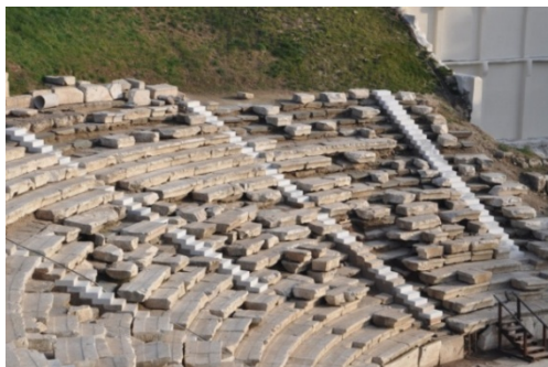
Εικ. 57: Νέες βαθμίδες κλιμάκων και τμήμα του πρανού στο βορειοανατολικό τμήμα του επιθεάτρου (ΕΣΠΑ θεάτρου Λάρισας)
