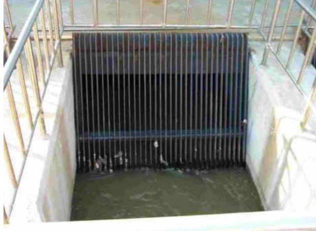
Εικόνα 2.7 Κάθετες σχάρες (Τσώνης, 2003).
