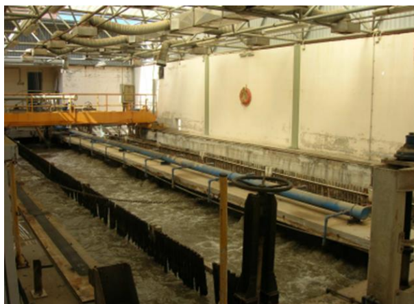
Εικόνα 4.3 Δεξαμενές αμμοσυλλογής και λιποσυλλογής ΕΕΛ Χανίων (Καρρά, 2008)
