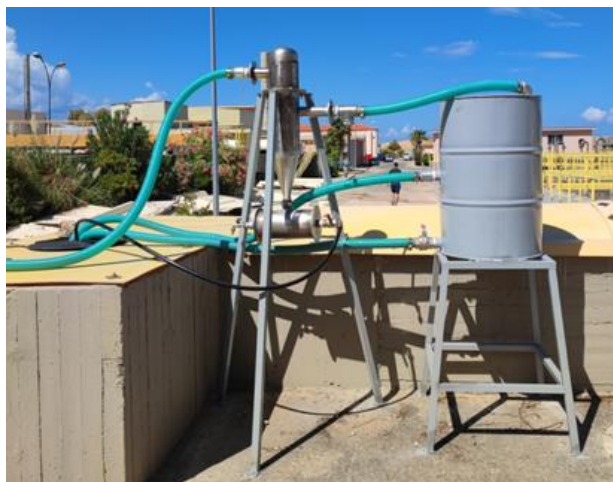
Εικόνα 5.1 Διάταξη υδροκυκλώνα στην ΕΕΛ Χανιών
