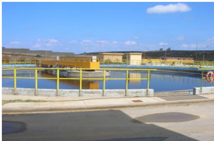
Εικόνα 4.6 Δεξαμενή δευτεροβάθμιας καθίζησης ΕΕΛ Χανίων (Καρρά, 2008)
