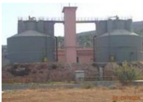
Εικόνα 4.8 Αναερόβιοι χωνευτές ΕΕΛ Χανίων (Καρρά, 2008)
