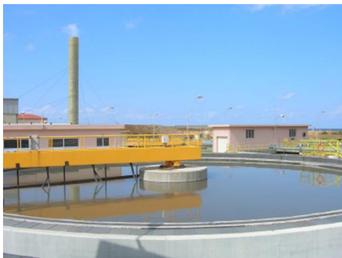
Εικόνα 4.4 Δεξαμενή πρωτοβάθμιας καθίζησης ΕΕΛ Χανίων (Καρρά, 2008)
