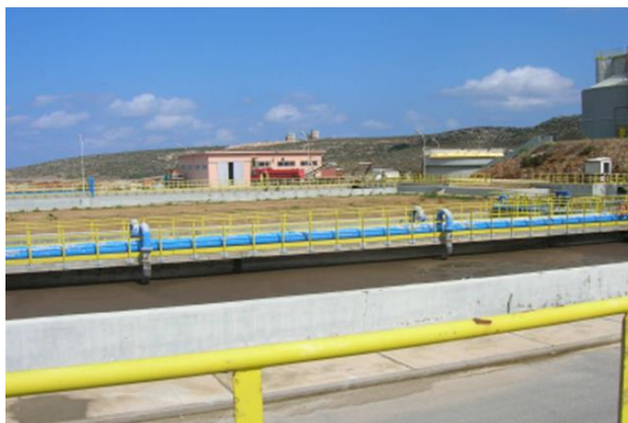
Εικόνα 4.5 Δεξαμενή αερισμού ΕΕΛ Χανίων (Καρρά, 2008)
