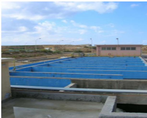
Εικόνα 4.7 Δεξαμενή χλωρίωσης ΕΕΛ Χανίων (Καρρά, 2008)
