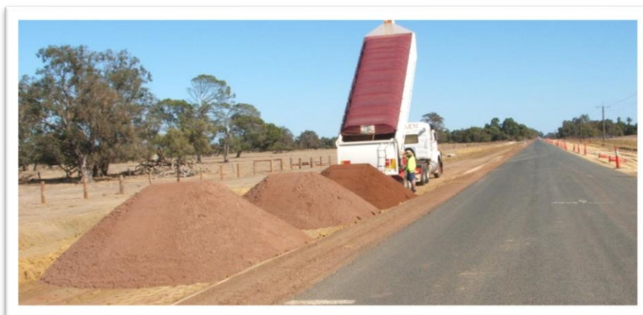
Εικόνα 5. Χρήση ερυθράς ιλύς για κατασκευή και επιδιόρθωση οδικών δικτύων.
