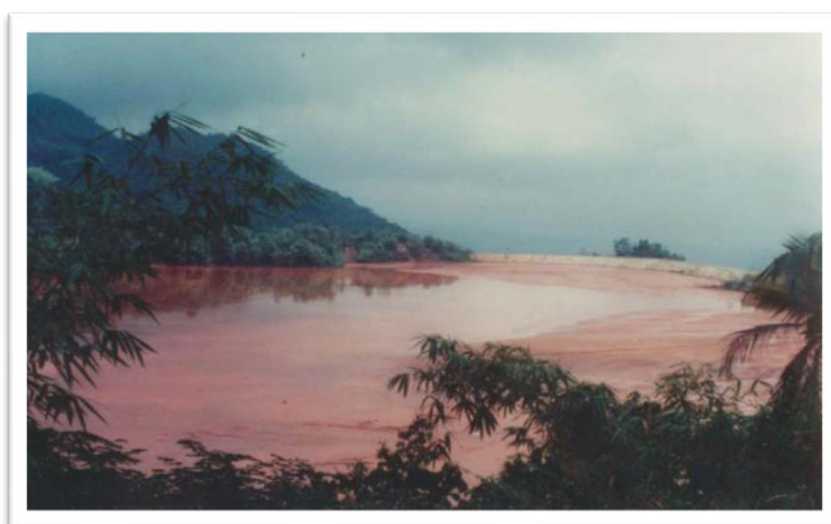
Εικόνα 3. Απόρριψη καταλοίπων βωξίτη σε ειδικά διαμορφωμένη λεκάνη στην Τζαμάικα (Evans 2016)
