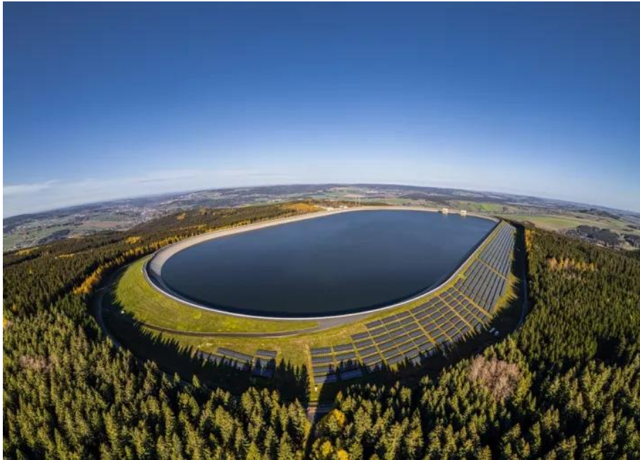
Εικόνα 35. Ταμιευτήρας χρησιμοποιούμενος για αντλιοσταμείωση έχοντας περιμετρικά του φωτοβολταϊκά πάνελ για παραγωγή πράσινης ενέργειας
