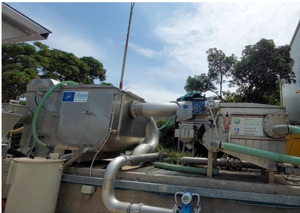
Εικόνα 1.4 Μικροκόσκινα εγκατεστημένα στην ΕΕΛ Ρεθύμνου.
