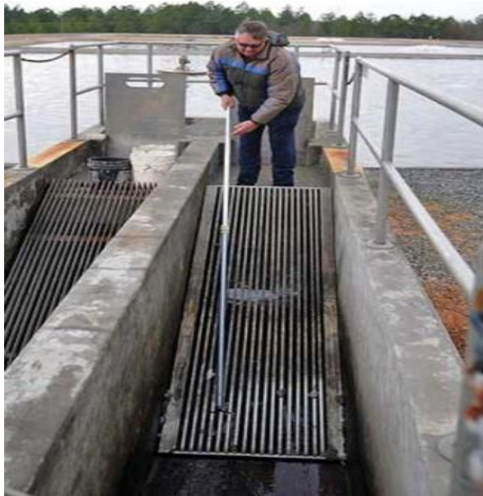
Εικόνα 1.2 Χειροκαθαριζόμενη σχάρα (Hill, 2020).
