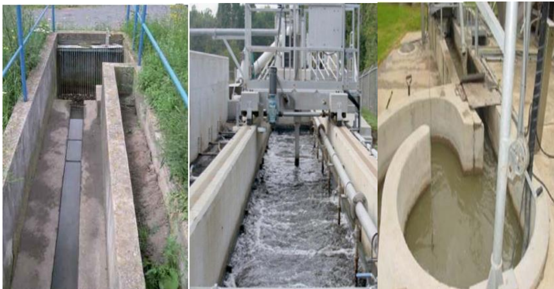
Εικόνα 1.5 Τύποι εξαμμωτών: σταθερής ροής, αεριζόμενος και τύπου δίνης (Γκίκας, 2020).
