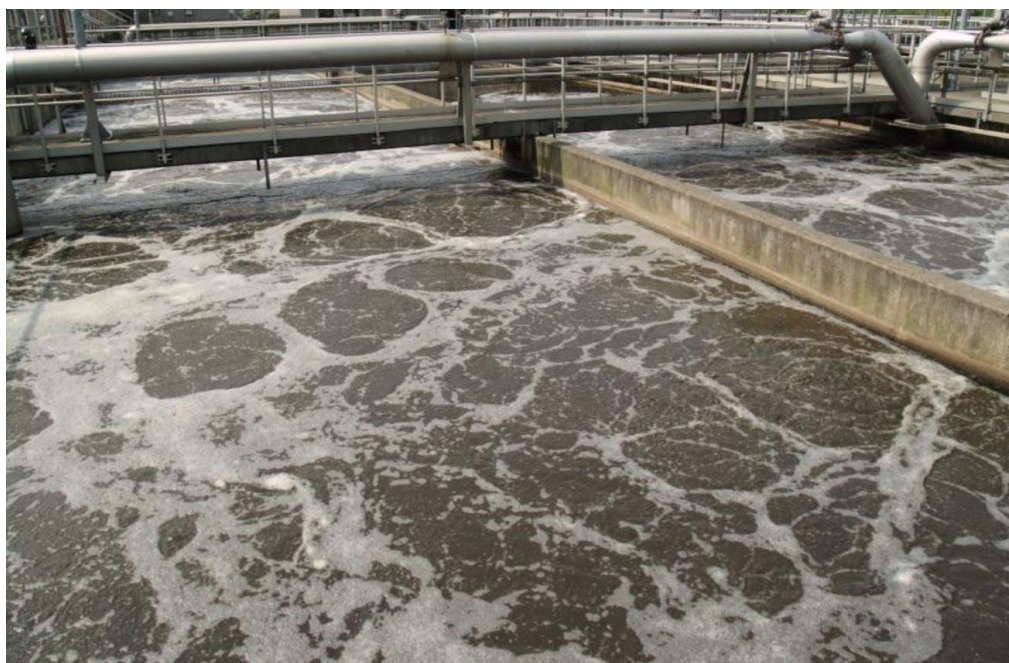
Εικόνα 1.7 Δεξαμενή Αερισμού (Theobald, 2017).
