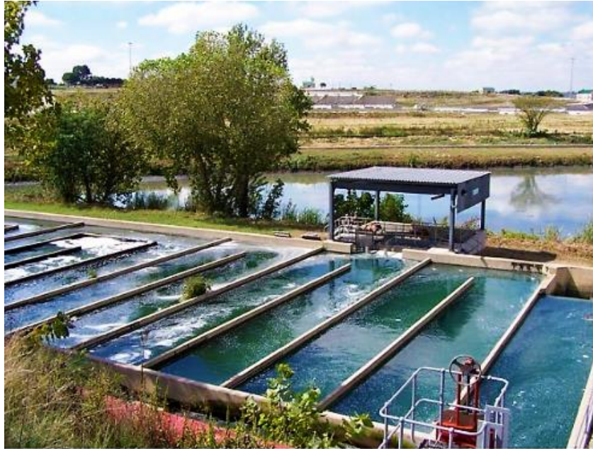
Εικόνα 1.8 Δεξαμενή Χλωρίωσης (Eawag, 2013).
