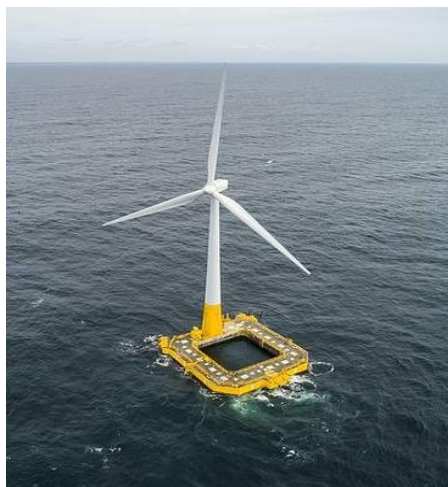
Εικόνα 11 Πλωτή ανεμογεννήτρια τύπου Barge[11]
