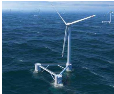
Εικόνα 8 Πλωτή ανεμογεννήτρια Ημιβυθισμένη (Semi-submersible) [9]
