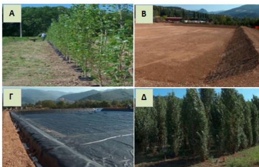
Εικόνα 4. Κατασκευή μονάδας φυτοαποκατάστασης OMW μεγάλης κλίμακας (Santori & Cicalini, 2002).
