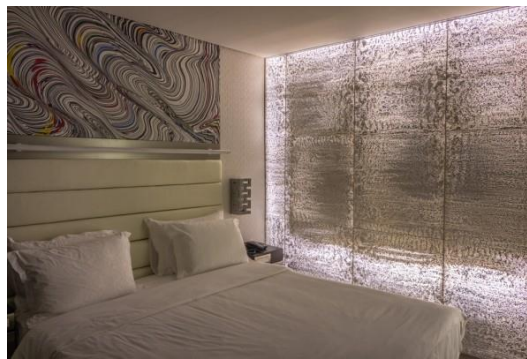
Εικόνα 35 | Πίσω από την επιφάνεια υπάρχει τεχνητή πηγή φωτισμού και το φως διαχέεται σε όλο τον χώρο χάρη στην χρήση διάφανου σκυροδέματος.
