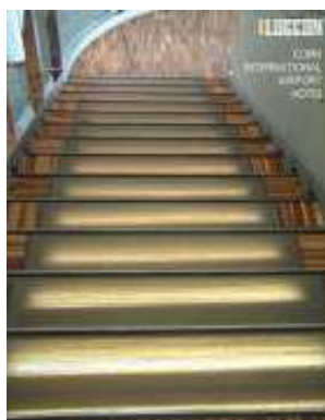
Εικόνα 31 | Αυτόφωτα σκαλοπάτια. Σύμφωνα με την βιβλιογραφία, δομικά στοιχεία αντίστοιχης λειτουργίας συμβάλουν στην ασφάλεια των χρηστών.
