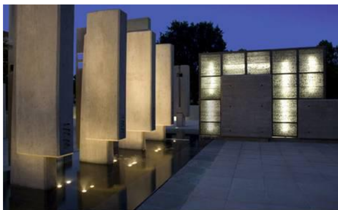
Εικόνα 21 | Εγκατάσταση με την χρήση διάφανου σκυροδέματος. Στην τοιχοποιία μπορούν να διακριθούν οι φωτεινές πηγές πίσω από την φωτοδιαπερατή επιφάνεια.
