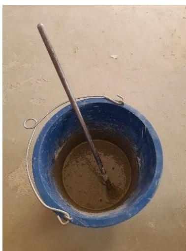
Φωτογραφία 15 | Ο τσιμεντοπολτός και τα αδρανή αναμειγνύονταν μέχρι να προκύψει ομοιογενές μείγμα έτοιμο για σκυροδέτηση.
