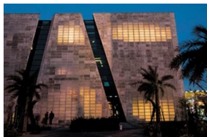
Εικόνα 27 | Ενιαία επιφάνεια πλήρωσης (χωρίς ανοίγματα), στην οποία το φως μεταφέρεται ανενόχλητο και προς τις δύο κατευθύνσεις.
