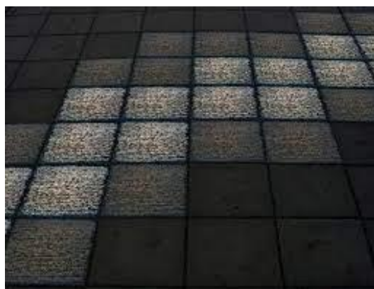
Εικόνα 1 | Δάπεδο κατασκευασμένο από πλάκες διάφανου σκυροδέματος. Κάτω από την επιφάνεια βρίσκεται η φωτεινή πηγή όπου δημιουργεί το αποτέλεσμα αυτό.
