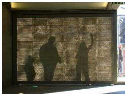
Εικόνα 6 | Τοιχοποιία από διάφανο σκυρόδεμα. Μπορούν να διακριθούν τα επί μέρους τμήματα (πλάκες διάφανου σκυροδέματος) ως μοναδικά δομικά στοιχεία που στο σύνολο τους αποτελούν τον φωτοδιαπερατό τοίχο.
