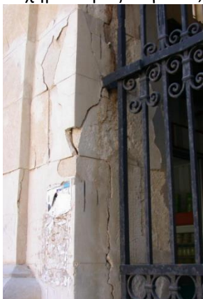
Εικ.24 Δημοτική Αγορά Χανίων - Διαρρήξεις από οξείδωση και διόγκωση μεταλλικών στοιχείων .
