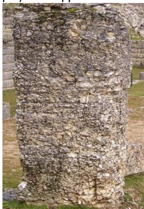
Εικ.25 Ιερό της Δωδώνης - Δράση του παγετού και πυκνές γεωλογικές ασυνέχειες.
