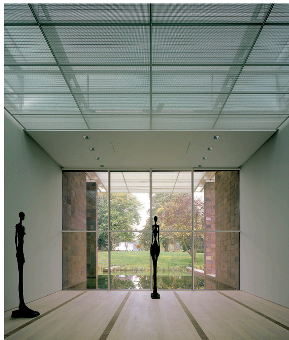
Εικόνα 91. Beyeler Foundation Museum, δεύτερη οροφή από διάτρητο μέταλλο
