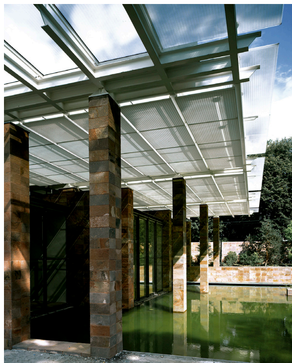
Εικόνα 92. Beyeler Foundation Museum, μεταλλική κατασκευή σχεδιασμένη για τη στήριξη της οροφής
