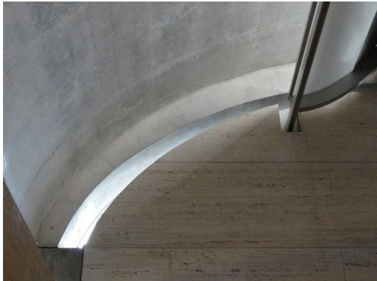
Εικόνα 73. Kimbell Art Museum Λεπτομέρεια θόλου από σκυρόδεμα και ανακλαστήρα φωτός από ανοξείδωτο χάλυβα
