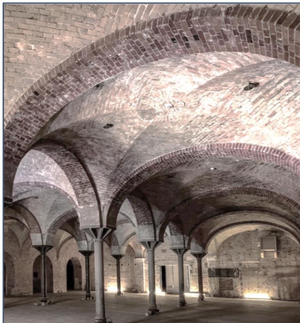
Εικ.79 : Οι θολωτές στηρίξεις της οροφής του υπόγειου χώρου.
