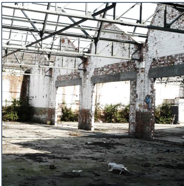
Εικ.90 : Το εγκαταλελειμμένο εργοστάσιο Malmar, σκελετός στέγης.
