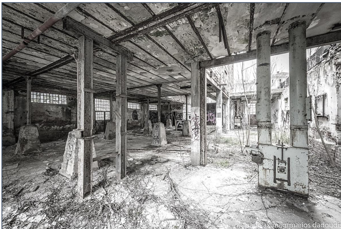
Εικ.23 : Σύστημα μεταλλικών υποστυλωμάτων, κύριων και δευτερευουσών δοκών
