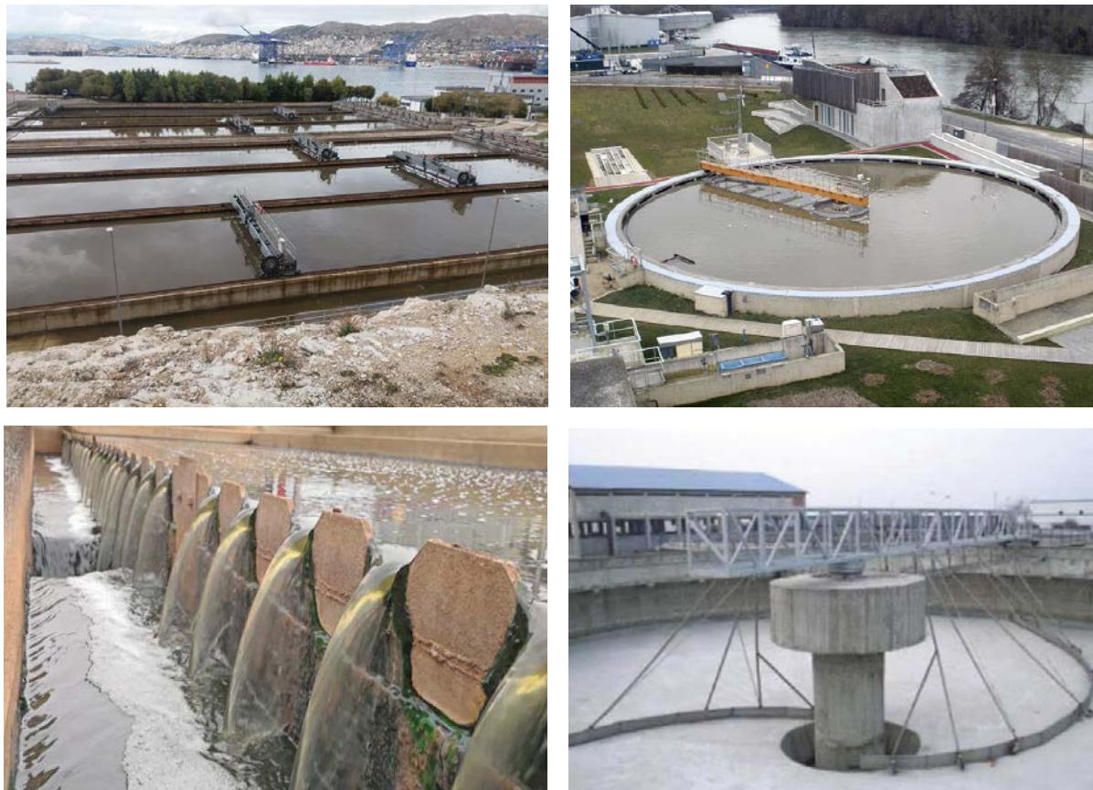
Εικόνα 1.3 ΔΠΚ ορθογωνικής διατομής (πάνω αριστερά), ΔΠΚ κυκλικής διατομής (πάνω δεξιά), υπερχειλιστής τραπεζοειδούς διατομής (κάτω αριστερά), ξέστρο παράσυρσης ιλύος με καμπύλες λεπίδες (κάτω δεξιά) (Γκίκας, 2020).
