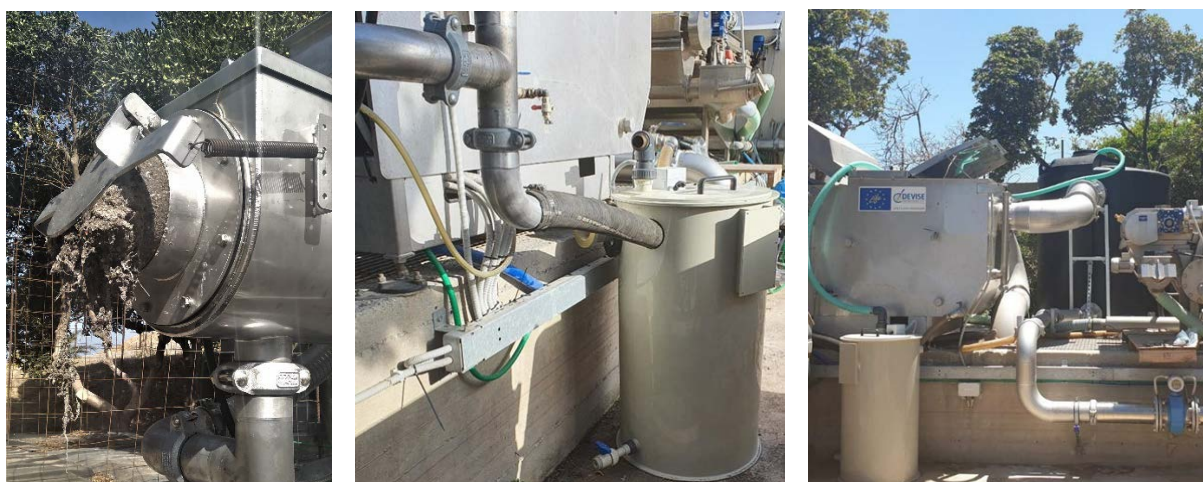
Εικόνα 5.6 Τα παραγόμενα μικροκοσκινισμένα βιοστερεά στην τελική τους μορφή (αριστερά), δεξαμενή ανάκτησης στερεών (μέση), μικροκόσκινο με σύστημα κροκίδωσης από πίσω του (δεξιά).
