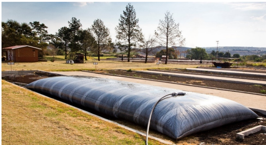
Εικόνα 2.8 Γεώσακος (geobag) που χρησιμοποιείται για αφυδάτωση ιλύος (GSSB, 2023).
