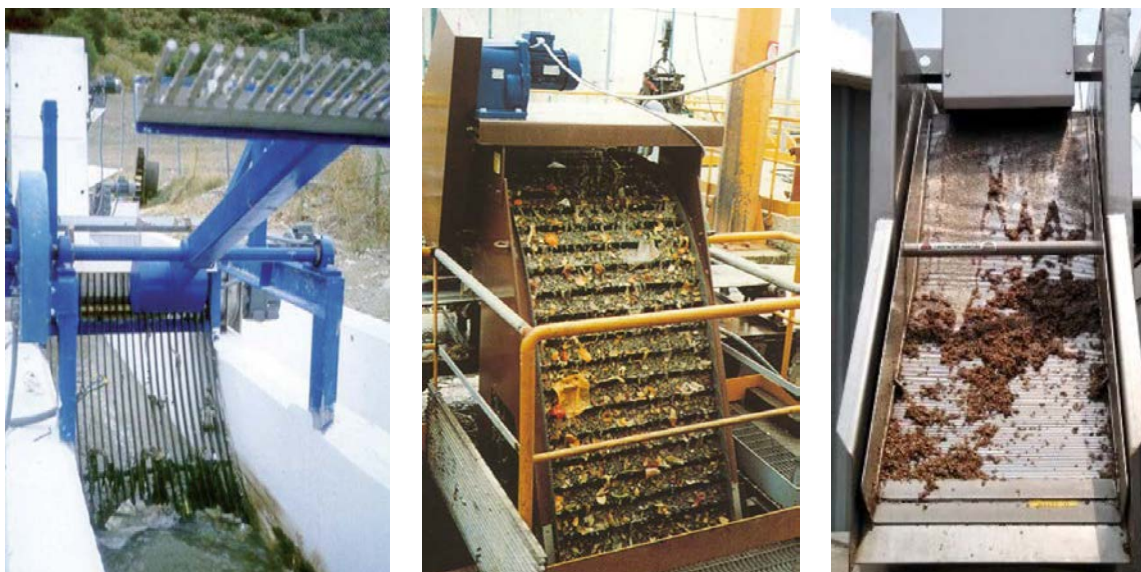
Εικόνα 1.1 Αυτοκαθαριζόμενη καμπύλη σχάρα (αριστερά), αυτοκαθαριζόμενη σχάρα κυλιόμενου ιμάντα (μέση), στατικό κόσκινο (δεξιά) (Γκίκας, 2020).
