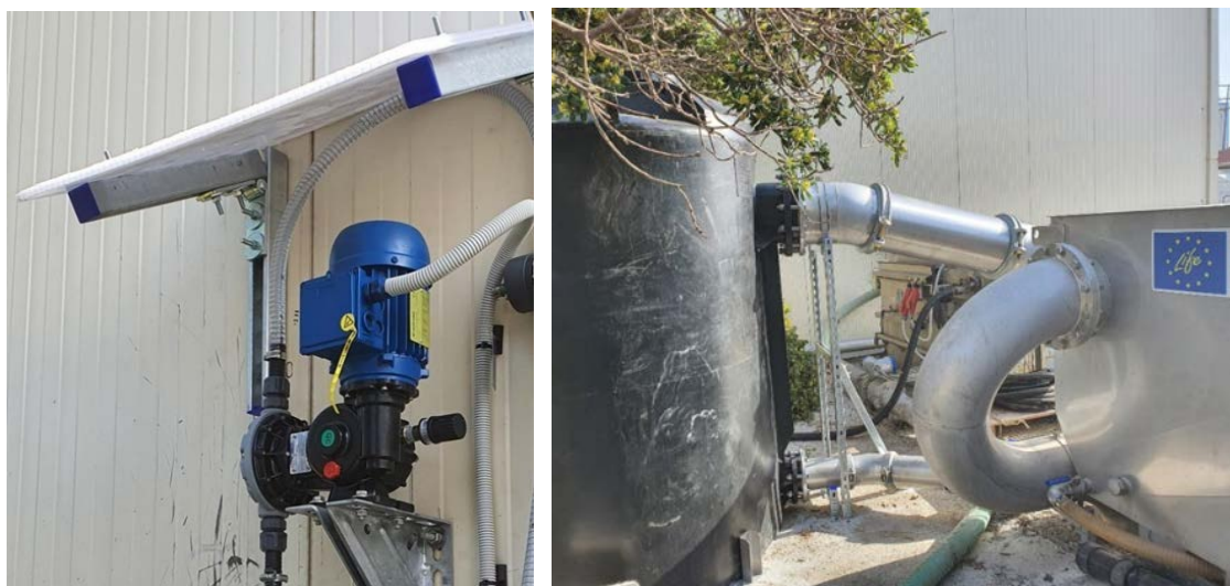
Εικόνα 10.1 Δοσομετρική αντλία (αριστερά) και δεξαμενή κροκίδωσης συνδεδεμένη με το πιλοτικό μικροκόσκινο (δεξιά).
