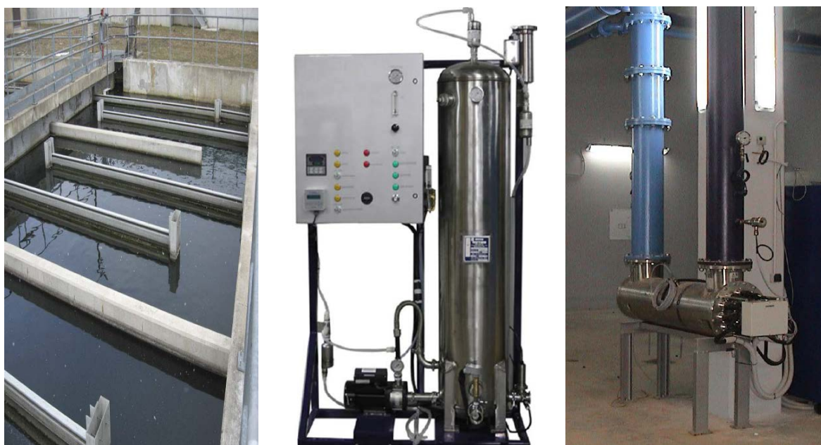
Εικόνα 1.4 Συστήματα απολύμανσης χλωρίωσης (αριστερά), οζονισμού (μέση), ακτινοβολήσης με UV (δεξιά) (Γκίκας, 2020).
