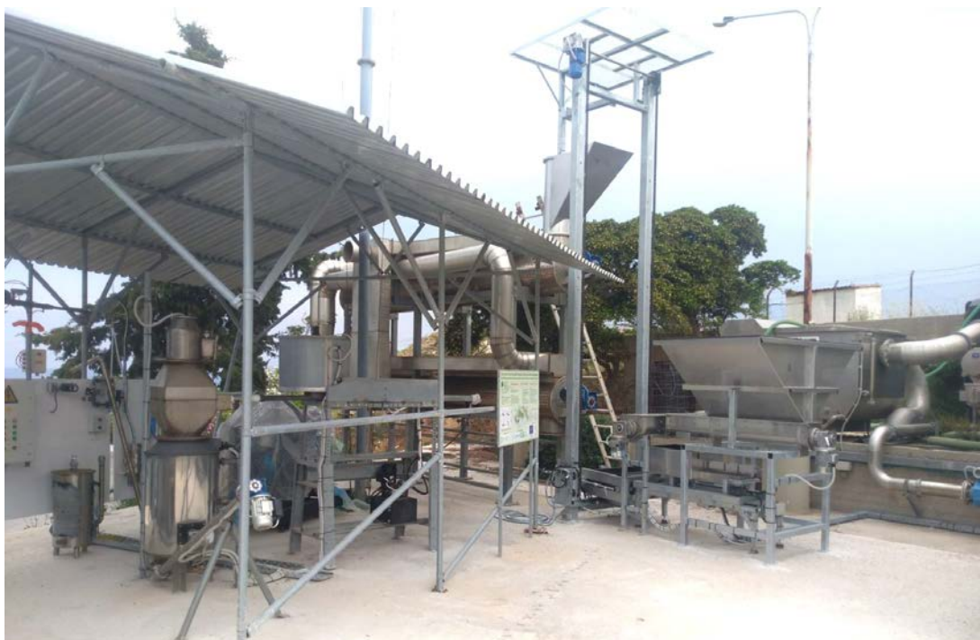
Εικόνα 5.3 Φωτογραφία της εγκατεστημένης πιλοτικής μονάδας προ-επεξεργασίας των λυμάτων και αξιοποίησης των παραγόμενων βιοστερεών του έργου LIFE B2E4sustainable-WWTP στην ΕΕΛ Ρεθύμνου.
