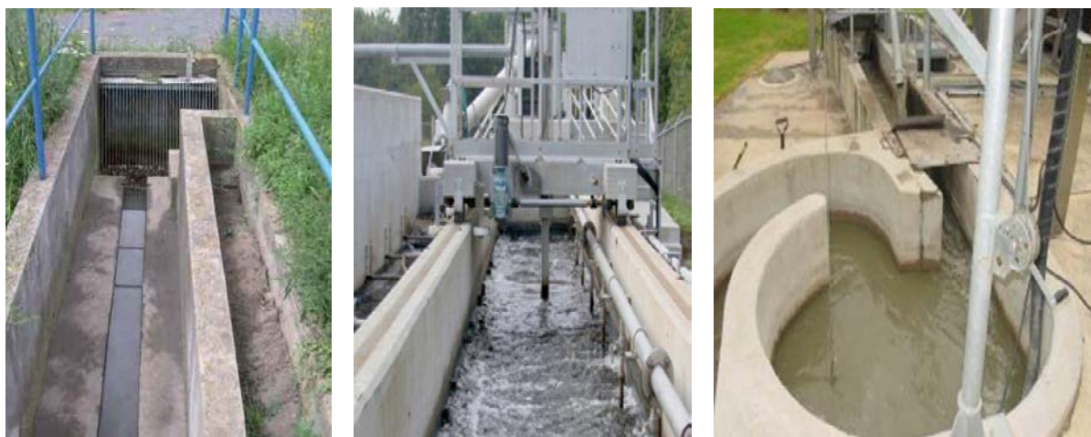
Εικόνα 1.2 Εξαμμωτής σταθερής ροής (αριστερά), αεριζόμενος (μέση), κυκλωνοειδούς ροής (δεξιά) (Γκίκας, 2020).
