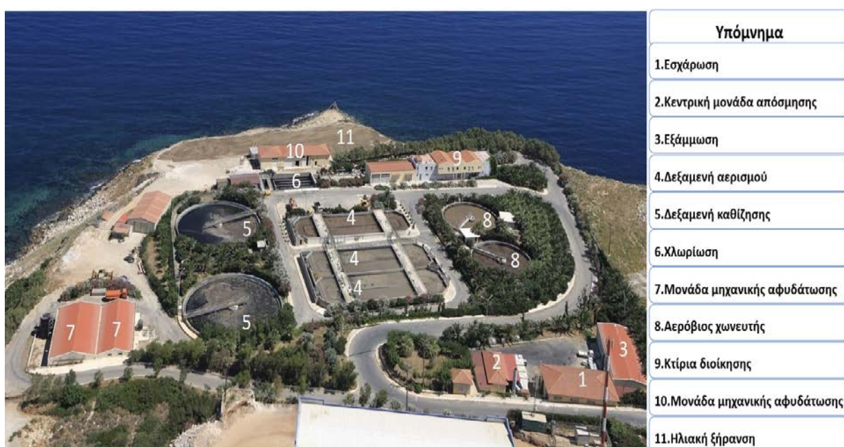
Εικόνα 3.1 Φωτογραφία της ΕΕΛ Ρεθύμνου, συνοδευόμενη από επεξηγηματικό υπόμνημα των εγκαταστάσεων / κτιρίων της.
