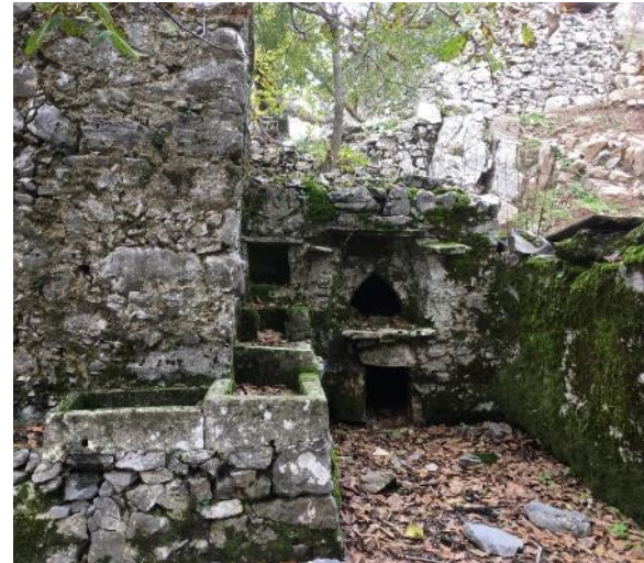
Οι χτιστές κατασκευές στην αυλή της κατοικίας 4.4. Στην φωτογραφία διακρίνεται ο πέτρινος φούρνος, οι χτιστές γούρνες για την συλλογή του βρόχινου νερού και ένας λαϊνοστάτης.
