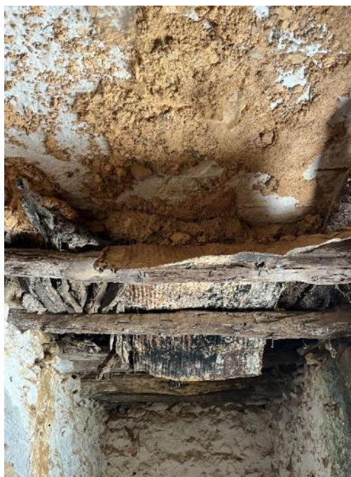
Πάνω: Κατοικία της οποίας έχει καταρεύσει το χωμάτινο δώμα, ωστόσο παραμένουν δοκοί και μεσοδόκια, στα οποία είναι εμφανής η ακατέργαστη μορφή των ξύλων καθώς και η μεγάλη διατομή τους.
