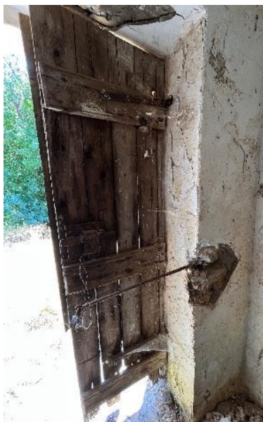
Η αμπάρα σε ξύλινο κούφωμα δίφυλλης θύρας σπιτιού και δεξιά λεπτομέρεια του πλέγματος σιδεριάς σε παράθυρο.
