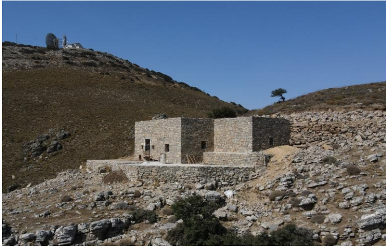
Νοτιοανατολική άποψη μιτάτου μετά την αποκατάσταση με τους τοίχους να εδράζονται πάνω σε κριπίδα.
