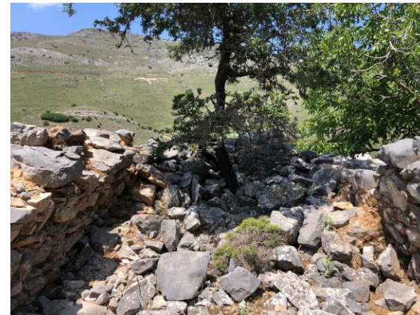
Εσωτερική δυτική άποψη κατοικίας που απεικονίζεται η ελαφριά κλίση των πλευρικών τοίχων με μείωση προς τα πάνω.
