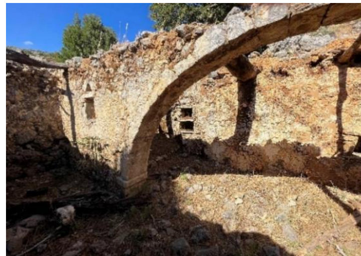
Εσωτερική άποψη της κατοικίας 7.2. Απεικονίζονται τα ανακουφιστικά τρίγωνα των ανοιγμάτων και οι λεπτές λίθινες πλάκες στην λιθοδομή.
