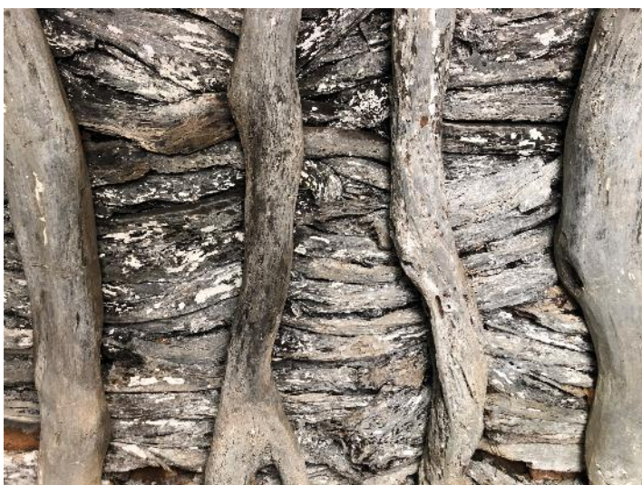
Εσωτερική άποψη του σκελετού της στέγης σε καμαρόσπιτο. Απεικονίζεται ο φέρον οργανισμός από τις ξύλινες ακατέργαστες δοκούς και οι σκίζες από πάνω.
