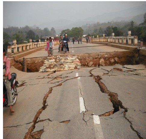
Εικόνα 2.10: Αστοχία οδικού πρηνούς λόγω πλευρικής εξάπλωσης στη Βιρμανία (2010).
