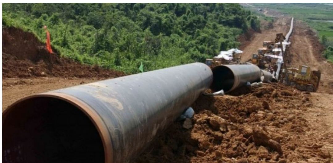
Εικόνα 3.1 Δημιουργία δικτύου σωληνώσεων μεταφοράς υγροποιημένου φυσικού αερίου (LNG).
