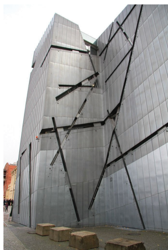
Εικόνα 89. Όψη μουσείου με μεταλλικά πάνελα ψευδαργύρου.
