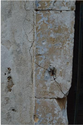
Εικόνα 6.3. Υπέρβαση θλιπτική αντοχής λιθοσσωμάτων Άγιος χρυσόστομος Κατσιφαριανά ( ιδία επεξεργασία)
