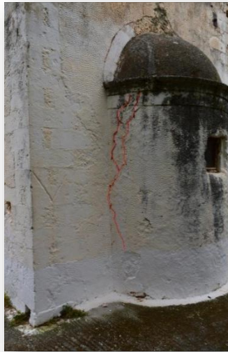
Εικόνα 6.11. Αστοχία σύνδεσης κόγχης με την τοιχοποιία του υπόλοιπου ναού ( ιδία επεξεργασία)
