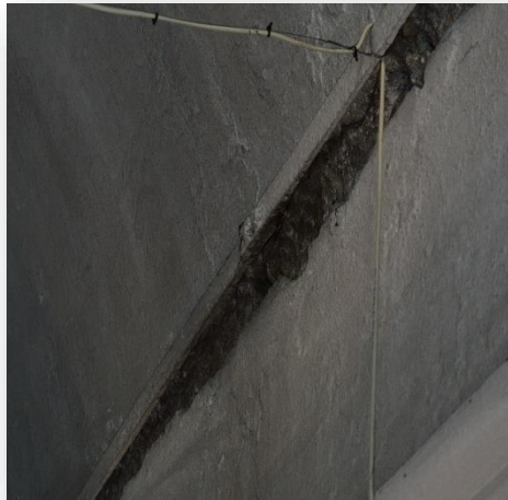
Εικόνα 6.2. Χαλάρωση τενόντων ελκυστήρα (Εκκλησία προφήτης Ηλίας στις Μουρνίες (ιδία επεξεργασία)
