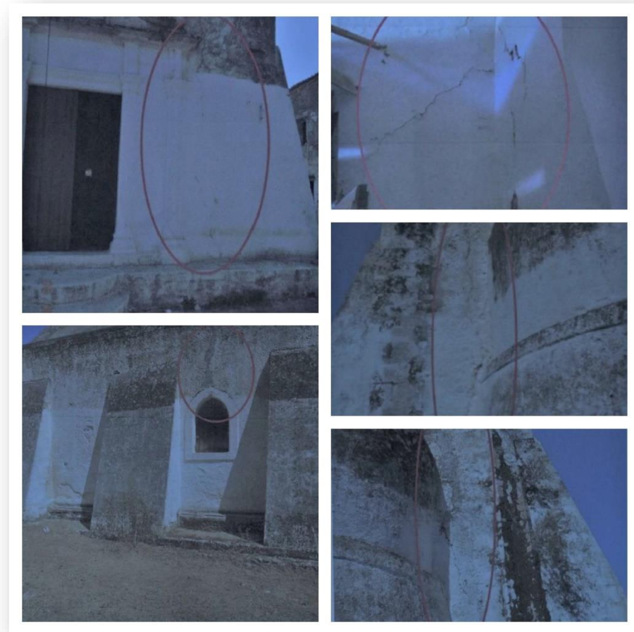
Εικόνα 9.40. Φωτογραφίες από τις δομικές βλάβες που είχε το καθολικό κατά το έτος 2018 (Αρχείο ΕΦΑ)
