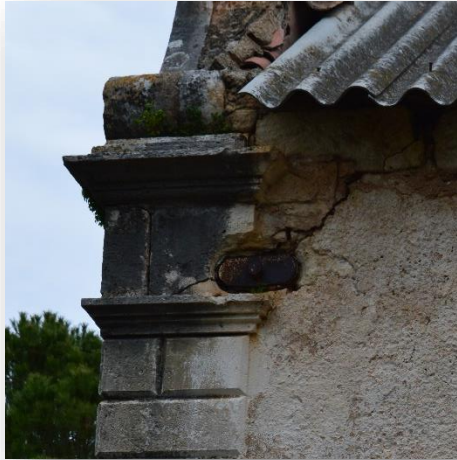
Εικόνα 6.1. Παρουσία μηχανισμού αστοχίας έναντι εφελκυσμού εκκλησία Προφήτης Ηλίας Μουρνιές (ιδία επεξεργασία)
