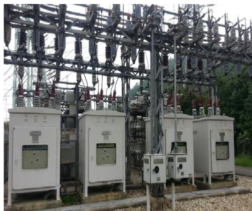
Σχήμα 4.3 Διακόπτης κυκλώματος κενού
