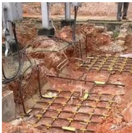
Σχήμα 4.9 Γείωση
