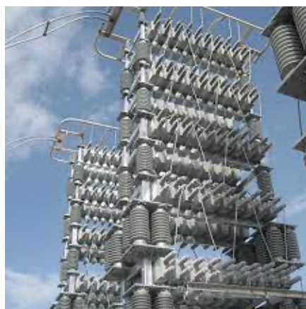
Σχήμα 4.8 Συστοιχία πυκνωτών
