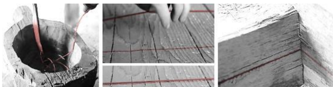
εικόνα 8 στιγμιότυπα σημαδέματος με σχοινί από ντοκιμαντέρ με θέμα την κατασκευή μεσαιωνικού κάστρου. (Timeline, 2018)
