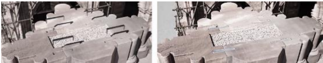
εικόνα 83 στιγμιότυπα από το ντοκιμαντέρ για τον καθεδρικό του Στρασβούργου στα αριστερά η σύνδεση των τμημάτων της κολώνας με σιδερένιους συνδετήρες, στα δεξιά η σφράγιση με μόλυβδο για την στερεοποίηση και προφύλαξη της σύνδεσης ( What Makes Strasbourg Cathedral An Architectural Masterpiece? [4K] / Extreme Constructions / Spark, 2019 )
