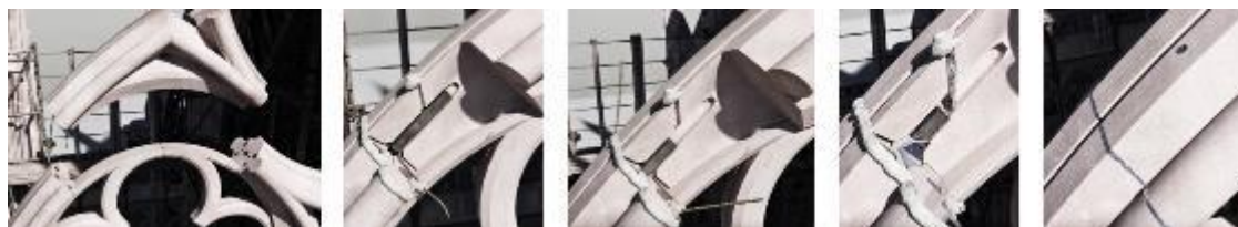
εικόνα 85 στιγμιότυπα από το ντοκιμαντέρ για τον καθεδρικό του Στρασβούργου, από τα αριστερά στα δεξιά μέθοδος τοποθέτησης ενίσχυσης σε δυσκολές τριγωνικό τμήμα (What Makes Strasbourg Cathedral An Architectural Masterpiece? [4K] / Extreme Constructions / Spark, 2019)
