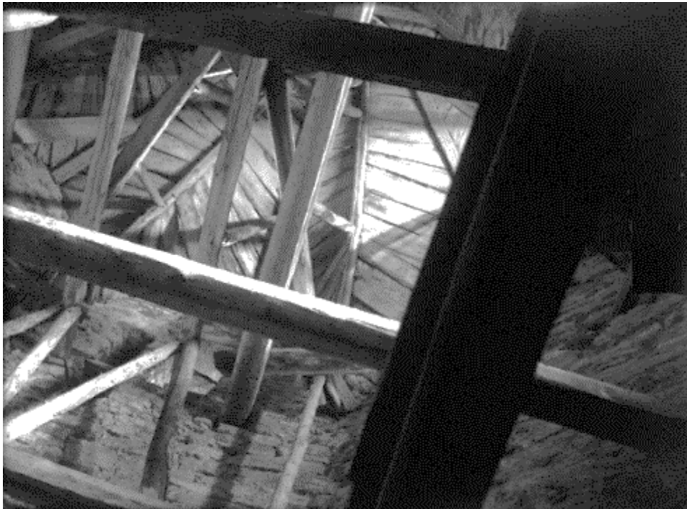
εικόνα 66 η σκαλωσιά και ο ξυλότυπος του καμπαναριού της εκκλησίας Lärbro στο Gotland της Σουηδίας. (Arts and Humanities Research Council & University of Liverpool, 2021)
