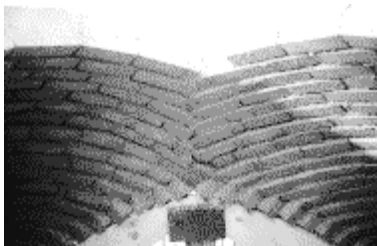
εικόνα 80 φωτογραφία κατασκευής από την πειραματική μελέτη: Vaults built without formwork: Comparison of the description of a traditional technique in building manuals with the results of practical observations and experimental studies (Wendland, 2022, p. 9)
