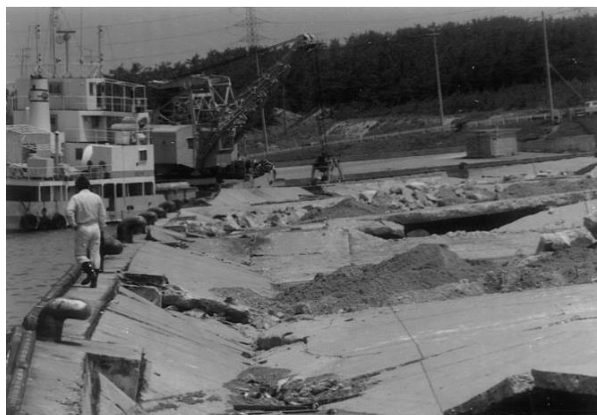
Εικόνα 2.15: Αστοχία λιμενικού πασσαλότοιχου στο λιμάνι Akita της Ιαπωνίας, από τον μεγάλο σεισμό Nihonkai-Chubu το 1983 (PIANC, 2001).
