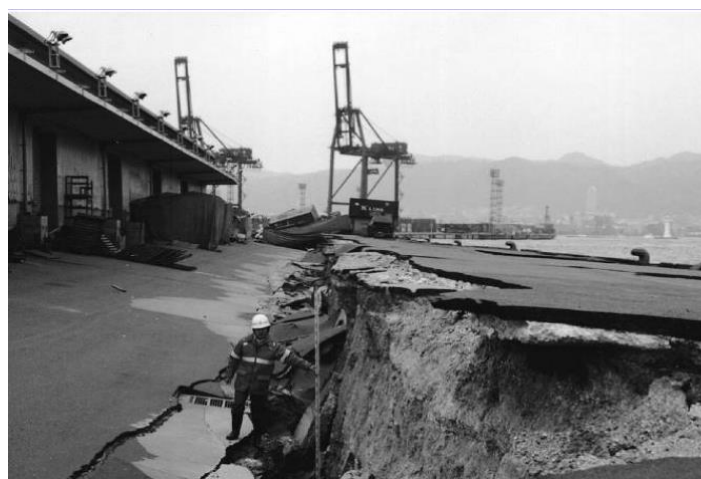
Εικόνα 2.11: Αστοχία κυψελωτού κρηπιδότοιχου βαρύτητας στο λιμάνι Kobe της Ιαπωνίας, από τον μεγάλο σεισμό Hanshin το 1995 (PIANC, 2001).
