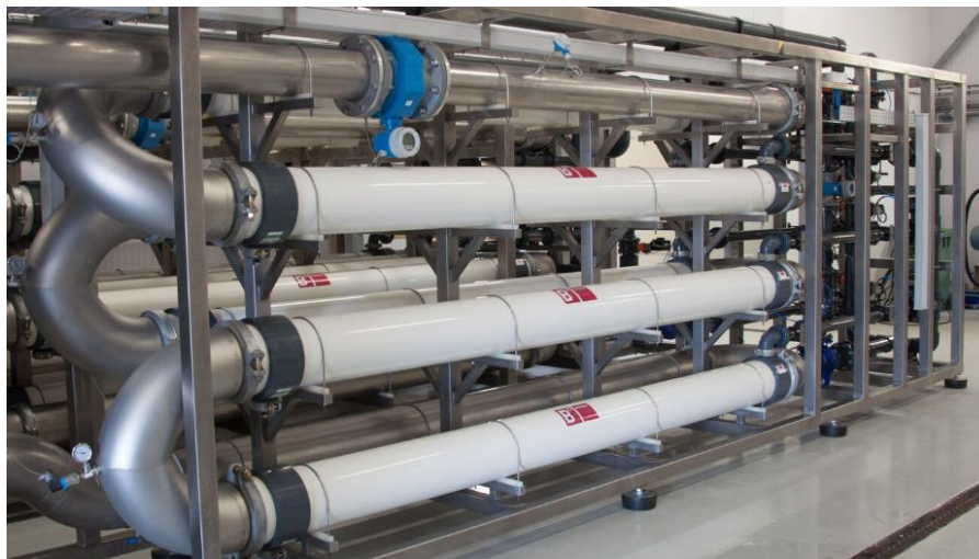
Εικόνα 2.4 Τεχνολογία μεμβρανών MBRs ( https://www.thembrsite.com/directories/membrane-products/berghof-b-smart-mbr/ ).
