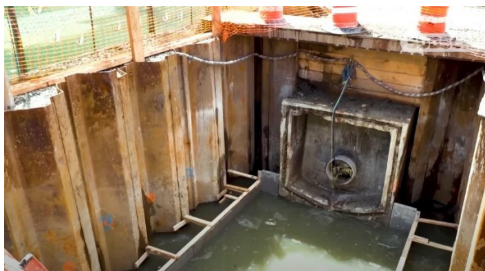
Εικόνα 40 «Θάλαμος παλίρροιας» υπό κατασκευή, Brooklyn 2022.
