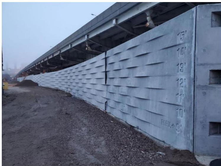
Εικόνα 36 Πρώτο ολοκληρωμένο τμήμα αντιπλημμυρικού τοίχου στο Stuyvesant Cove Park, Manhattan. Ιούλιος 2021. Πηγή: NYC Department of Design and Construction (DDC)
