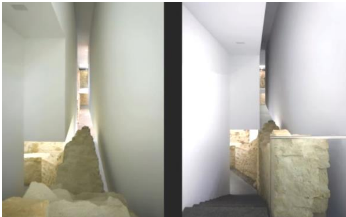
Εικόνα 65. Φωτογραφίες από το εσωτερικό στις περιοχές όπου τα οι αρχαιότερες τοιχοποιίες διατηρούνται σε εγγύτητα αλλά όχι σε επαφή, με τη νεότερη κατασκευή. Πηγή εικόνας διάλεξη της Fuensanta Nieto, Lightscapes: a daylight talk, https://www.youtube.com/watch?v=ChBki0DT87w , (τελευταία προσπέλαση 21/05/2023)
