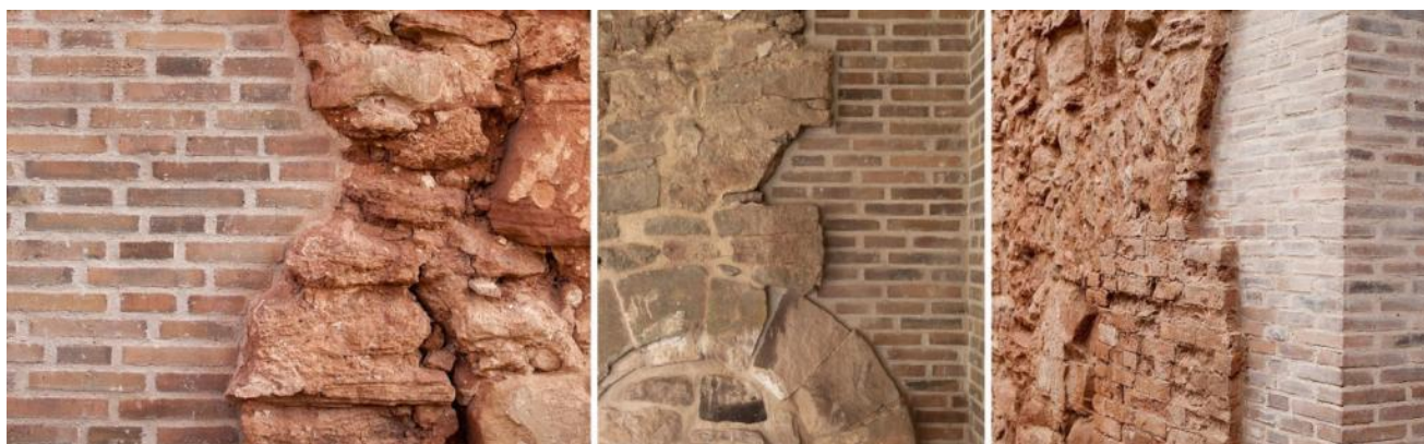
Εικόνα 50. Νέα τοιχοποιία και υφιστάμενη. Λεπτομέρειες συναρμογών. Διαδικτυακές πηγές: Landmark Trust (αριστερά), Journal du design (μεσαία), Pinterest (δεξιά).
