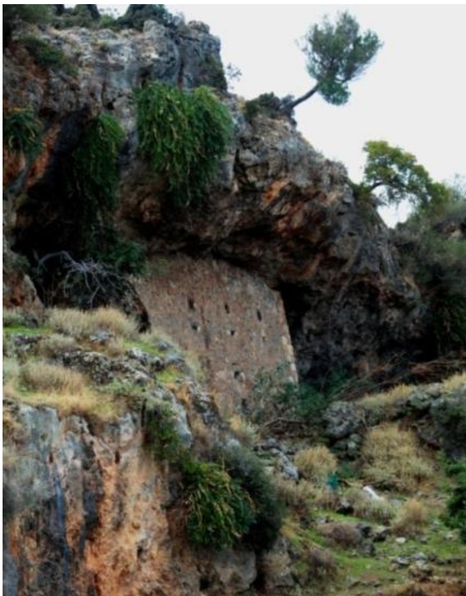
Εικόνα 30. Χανιά. Μετατροπή σπηλαίου σε κτήριο, με τη πλήρωση της εισόδου του από λιθοδομή με ανοίγματα. Λήψη: Λιόφαγος Γιάννος.
