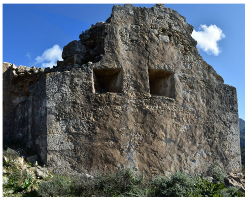
Εικόνα 42: Λαξευμένοι γωνιόλιθοι στον Κουλέ Επισκοπής. Πηγή: Προσωπικό αρχείο
