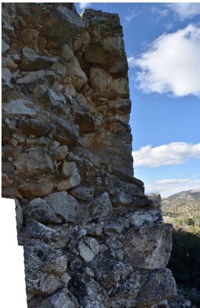
Εικόνα 43: Κουλές Επισκοπής. Περιπτώση όπου έχουν αφαιρεθεί οι γωνιόλιθοι. Πηγή: Προσωπικό αρχείο
