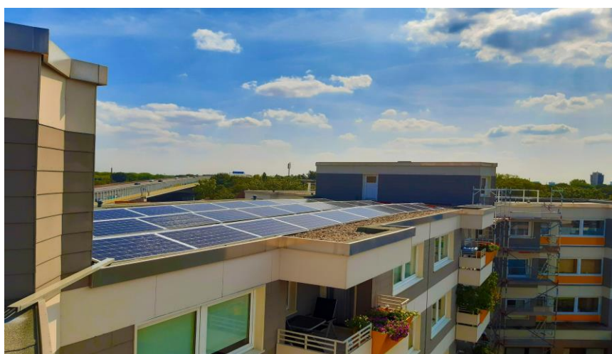
Εικόνα 2-1. Φωτοβολταϊκό σύστημα σε οροφή πολυκατοικίας.
