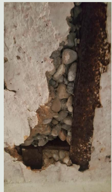
Οπλισμένο σκυρόδεμα με υψηλή περιεκτικότητα ποταμίσια βότσαλα
