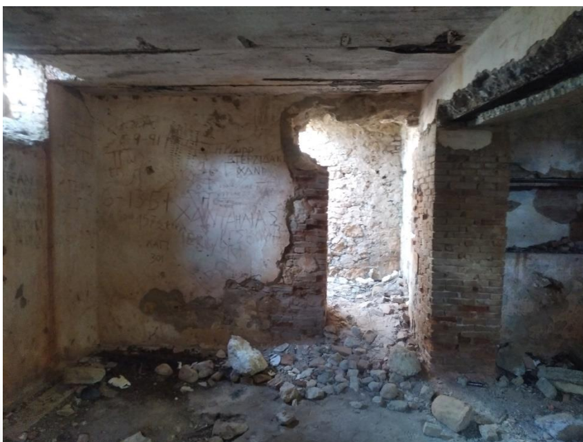
Πτώση λίθων και επιχρίσματος – Ανθρωπογενής φθορά (χαράξεις και απόσπαση πρεκτιού)
