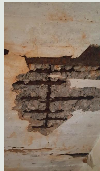
Οξείδωση οπλισμού και πτώση επιχρίσματος
