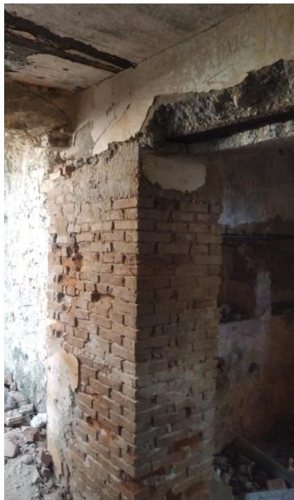
Υποσύλωμα από οπτόπλινθους και δοκός από οπλισμένο σκυρόδεμα
