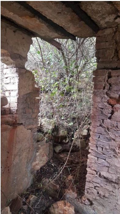
Κατάρρευση οπτοπλινθοδομής και έντονη δράση του φυτικού στοιχείου
