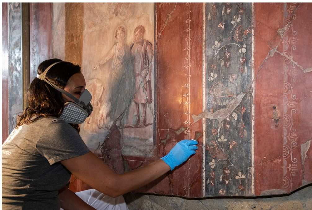
Εικ. 40: Πλύση τοιχογραφίας πριν την ενεμάτωση, (WIKIMEDIA COMMONS, 2020)
