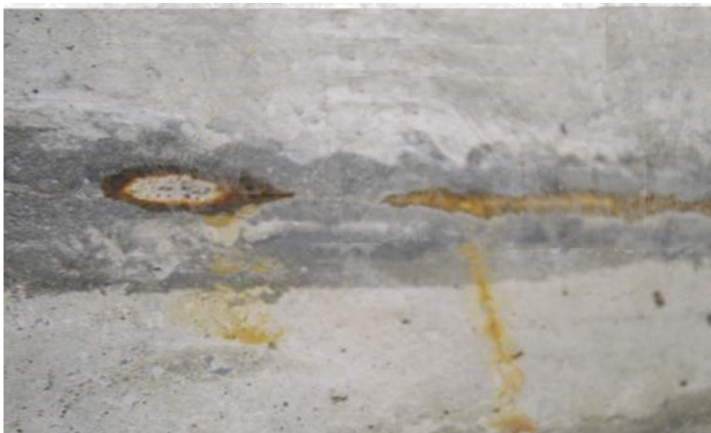
Εικ. 8: Παράδειγμα εφαρμογής μη συμβατού ενέματος, (FUNAHASHI AND SIROLA 2014)
