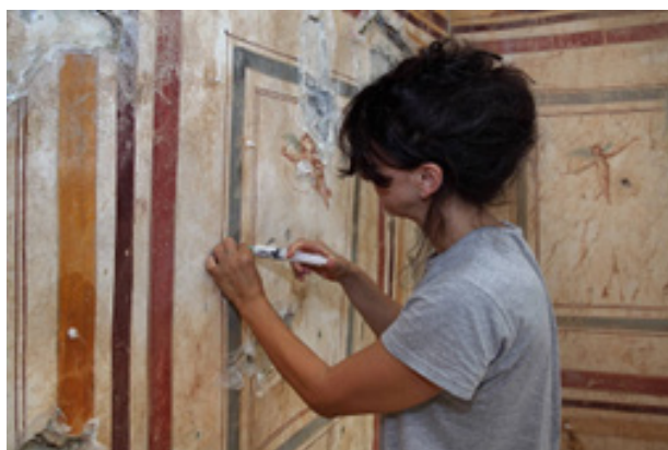
Εικ. 41: Έγχυση ενέματος με σύριγγα, (WIKIMEDIA COMMONS, 2020)
