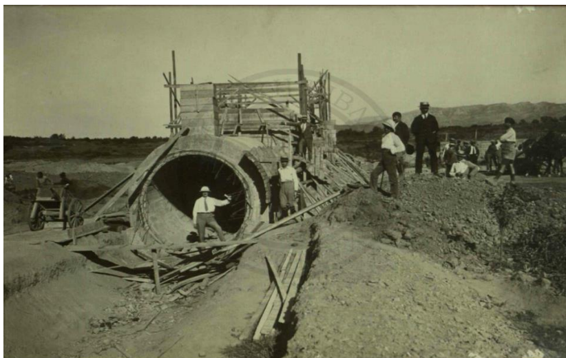
Εικόνα 56: Κατασκευή αγωγού προσαγωγής υδάτων στη λίμνη της Αγιάς
