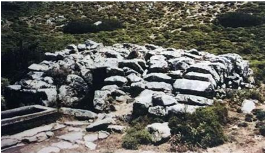
Εικόνα 96. Η μεγάλη θολωτή πετρόχτιστη στέρνα στο μιτάτο Τρικούκιδα. Μπροστά της λίθινη ορθογώνια λαξευτή γούρνα
