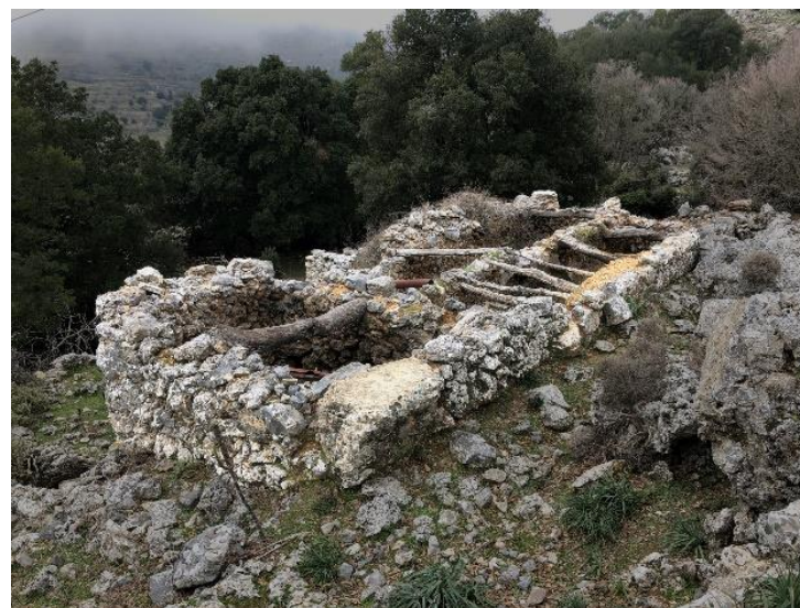
Εικόνα 123. Ότι έχει απομείνει από τα δοκάρια της οροφής σε σπίτι στη γειτονιά Κούκουρου
