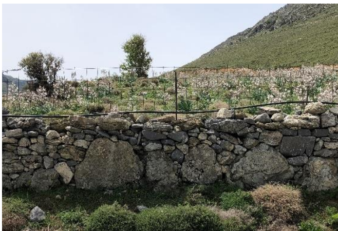
Εικόνα 144. Αναλημματικός ξερολιθικός τοίχος
