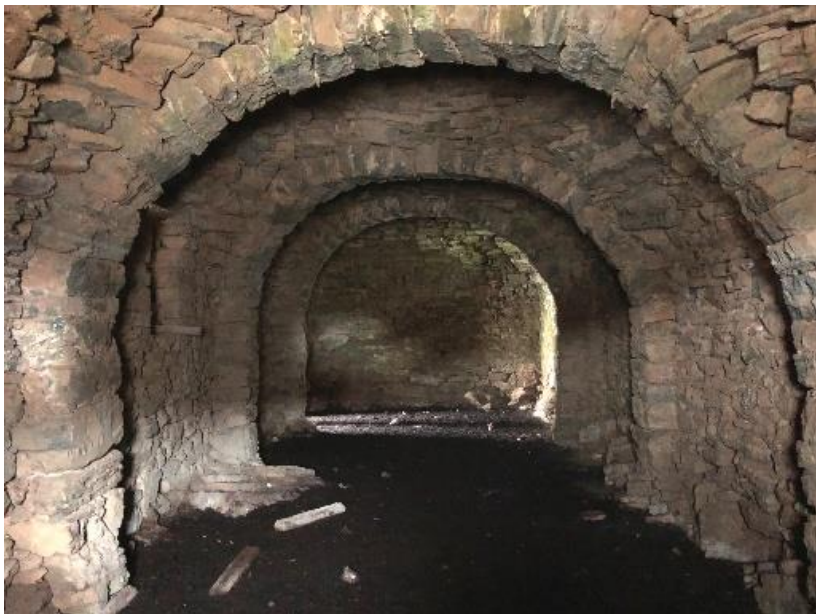
Εικόνα 124. Το μιτάτο Ξηρουχάκηδων με την θολωτή οροφή
