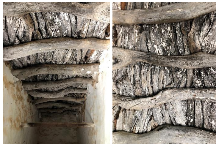
Εικόνα 122. Οροφή σε καμαρόσπιτο στη γειτονιά Χατζή
