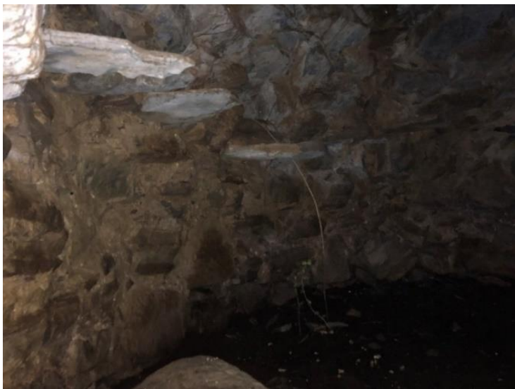
Εικόνα 107. Εσωτερικό του δεύτερου μεγάλου κούμου με χωνευτές πλάκες στους τοίχους για ράφια
