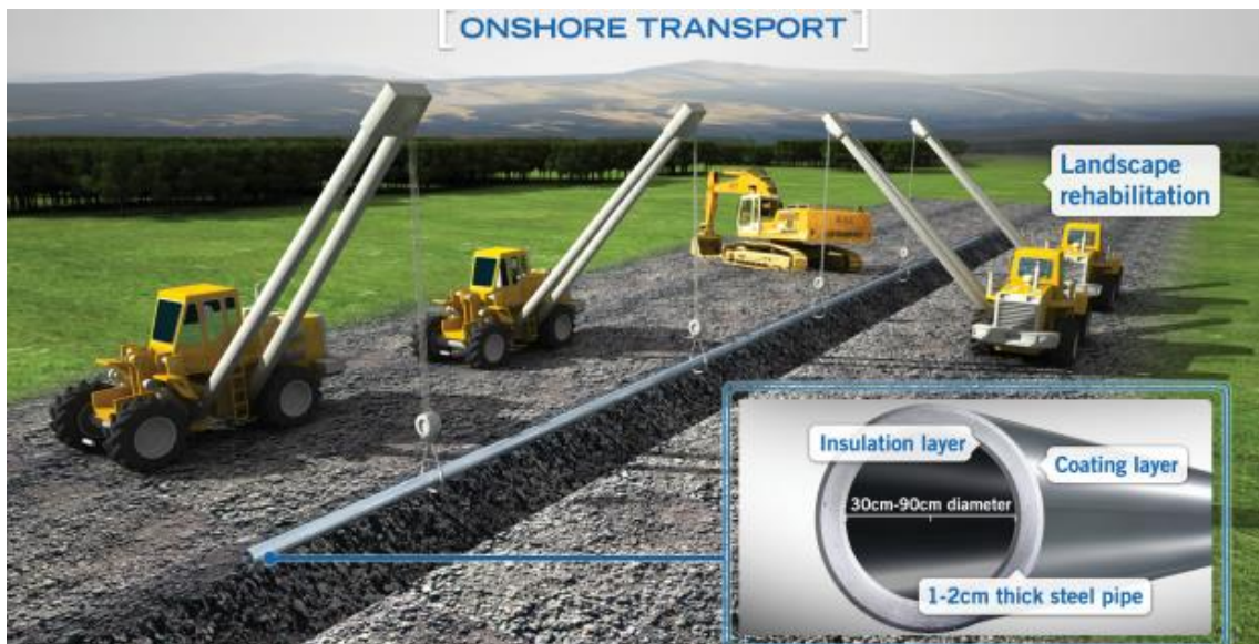
Εικόνα 40: Εγκατάσταση χερσαίου δικτύου αγωγών για την μεταφορά διοξειδίου του άνθρακα στην τελική τοποθεσία αποθήκευσης του (INSTITUTE, n.d.)
