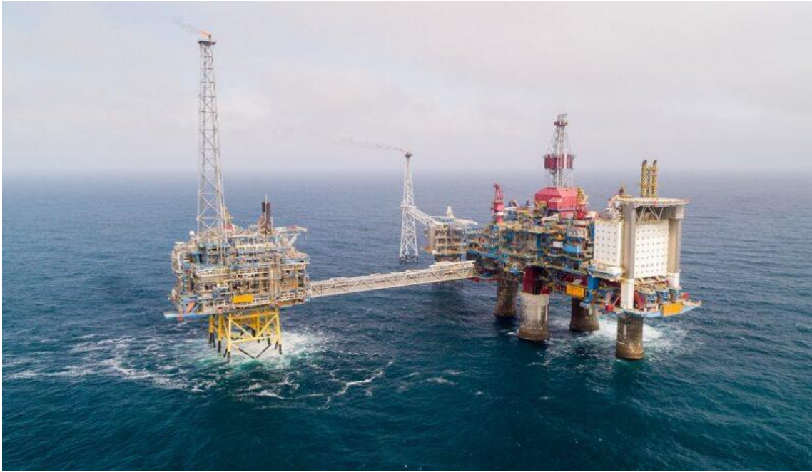
Εικόνα 48: Η πλατφόρμα στο Sleipner όπου γίνεται ο διαχωρισμός του διοξειδίου του άνθρακα από τους παραγόμενους υδρογονάνθρακες (Flowers, 2020)
