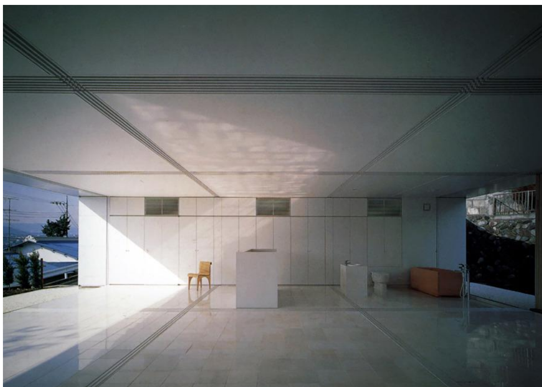
Εικόνα 49 Εσωτερική όψη των οδηγών των συρόμενων θυρών
