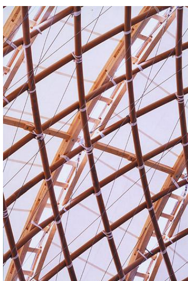
Εικόνα 17 Κατασκευαστική λεπτομέρεια, πλέγμα, σύνδεση ξύλινων στοιχείων
