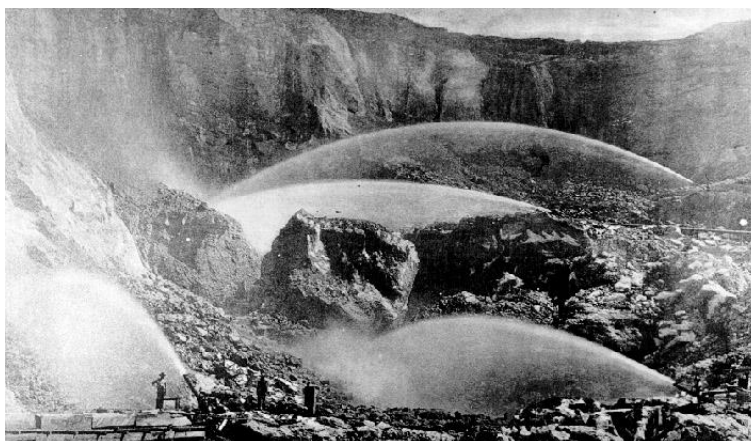
Εικόνα 1- 7: Η εφαρμογή των κανονιών νερού στο ορυχείο North Bloomfield, στην Καλιφόρνια, κατά την διάρκεια της εποχής του «πυρετού του χρυσού» (Ridgley, 2018)
