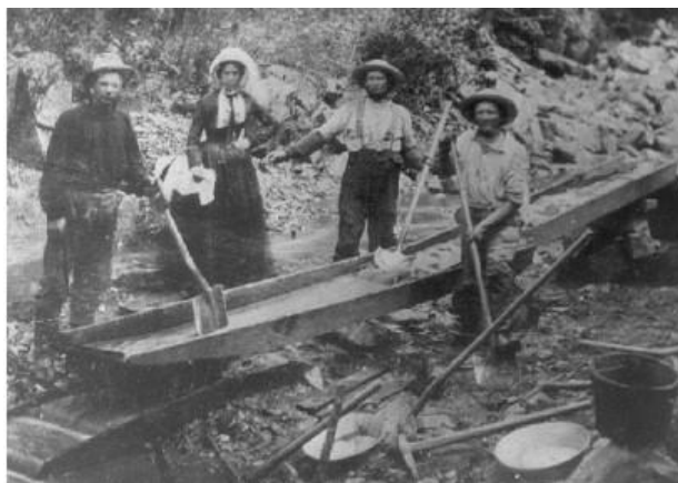
Εικόνα 3- 10: Υδροσυγκεντρωτής Long Tom που χρησιμοποιήθηκε στην πόλη Auburn της Καλιφόρνια
