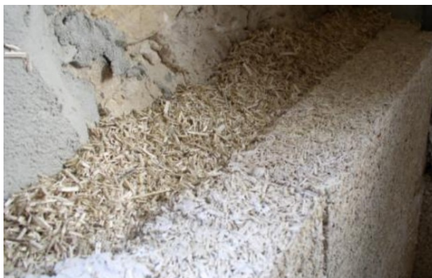
Εικόνα 112: Τοποθέτηση του μπλοκ σε απόσταση από τον τοίχο
