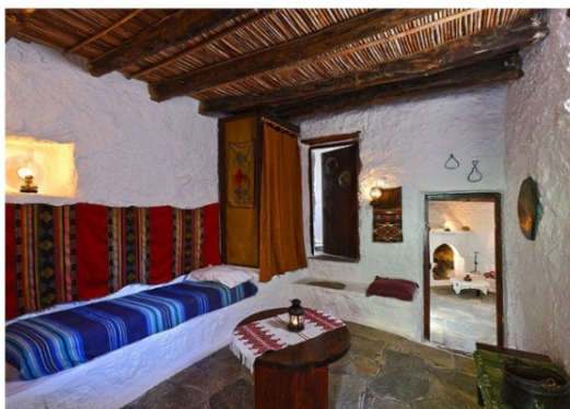
Εικόνα 45: Ταβάνι με καλάμια
