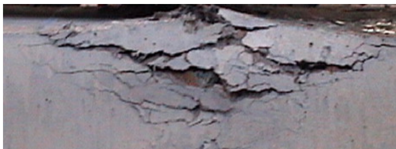
Εικόνα 41: Διόγκωση τούβλων από υγρασία και σπάσιμο σοβά( https://www.nature.com )
