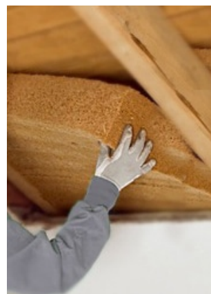
Εικόνα 32: Εγκατάσταση Ξυλόμαλλου
