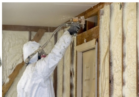
Εικόνα 5: Μόνωση πολυουρεθάνης μέθοδος ψεκασμού ( https://www.paragon-protection.com )
