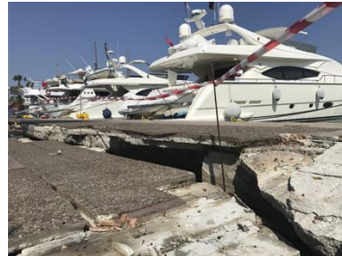
Εικόνα 86: Φωτογραφία ρήγματος στο λιμάνι της Κω λίγο μετά το σεισμό του 2017
