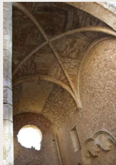
Εικόνα 38: Η στέγαση του προσβυτερίου του ναού με έναν σταυρωτό γοτθικό και έναν κυλινδρικό θόλο.
