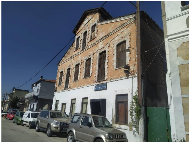
Εικόνα 69. Το κουκουλόσπιτο του Πίττα στην οδό Παπαναστασίου το οποίο λειτουργεί σήμερα ως κέντρο νυχτερινής διασκέδασης στο ισόγειο. Παρατηρούμε εξωτερικό επίχρισμα, προσθήκη ταμπέλας και αλλαγή των κουφωμάτων τα οποία έχουν καλυφθεί ώστε να μην περνάει φως στο εσωτερικό του κτιρίου. Ο όροφος και η σοφίτα δεν λειτουργούν, βλέπουμε εξωτερικές φθορές λόγω υγρασίας.
