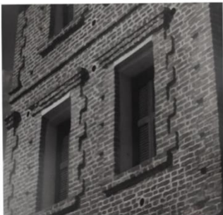
Εικόνα 49. Περίθυρα με πλινθόκτιστες οδοντώσεις.
