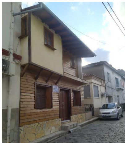
Εικόνα 82. Κτίριο στην οδό Φλώρου, μίμηση της παραδοσιακής τεχνικής του σαχνισιού.
