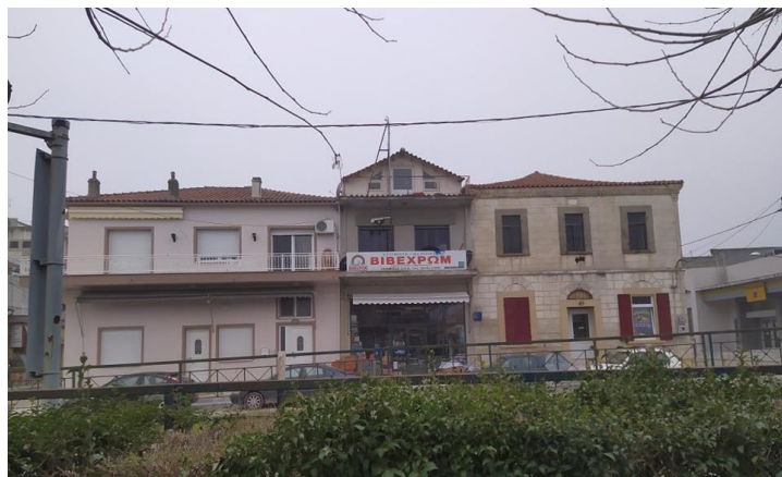
Εικόνα 86. Προσθήκη ορόφων στο μεσαίο κτίριο και αλλαγές ανοιγμάτων καθώς και προσθήκη ενιαίου εξώστη στο κτίριο αριστερά.
