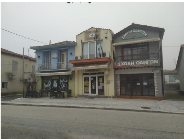
Εικόνα 68. Το κτίριο του Τόλκα στην οδό Β. Γεωργίου, στο οποίο έγιναν πολλές επεμβάσεις όπως η διάνοιξη μεγαλύτερων ανοιγμάτων τόσο στο ισόγειο όσο και στον όροφο, αλλαγή του εξώστη με χρήση μπετόν, προσθήκη τέντας και ταμπέλας.
