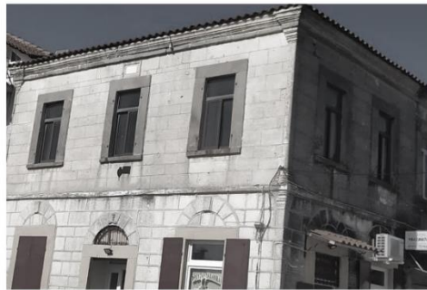
Εικόνα 46. Διαμόρφωση γωνιών με λαξευτούς λίθους και λίθινα χαμηλωμένα τόξα.
