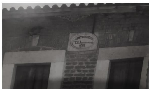
Εικόνα 49. Περίθυρα με πλινθόκτιστες οδοντώσεις.
