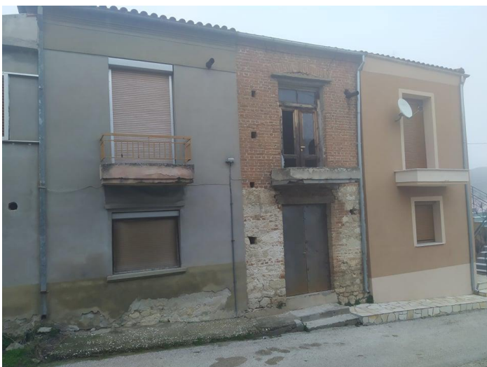
Εικόνα 92. Κτίρια στην πλατεία Νίκης. Τρία κτίρια με παρόμοια ανοίγματα στην νότια όψη τους, παρατηρούνται διαφορετικές φάσεις. Αριστερά σοβάς και κουφώματα αλουμινίου δεκαετίας '70, στην μέση εγκατάληψη χωρίς επίχρισμα με ξύλινα κουφώματα. Ενώ δεξιά η πιο σύγχρονη εκδοχή με πρόσφατη αποκατάσταση, επίχρισμα με χρώμα, νέα κουφώματα και δορυφορικό πιάτο.
