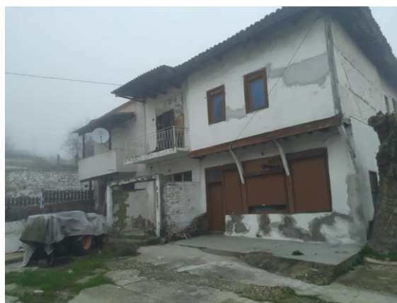
Εικόνα 75. Κτίριο στην πλατεία Νίκης, το κατάστημα με το παραδοσιακό σαχνισί παρουσιάζει έντονη μορφολογική αλλοίωση στο ισόγειο με προσθήκη ανοιγμάτων και χρήση κουφωμάτων αλουμινίου.
