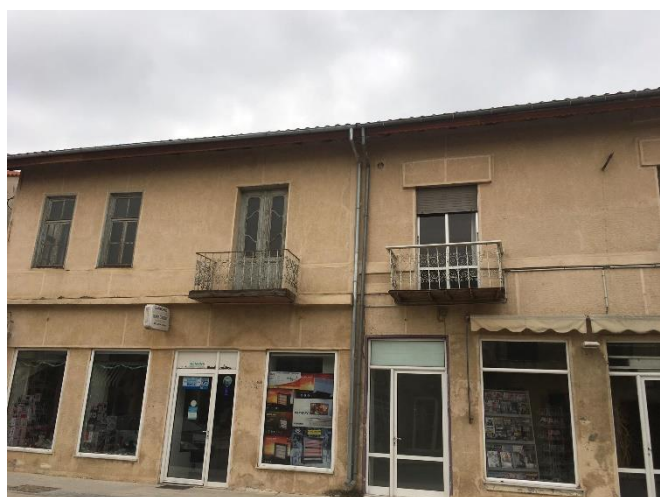
Εικόνα 74. Κτίριο στο κέντρο του οικισμού στην οδό Β. Γεωργίου, το ισόγειο μοιράζεται σε δύο καταστήματα στα οποία έχουν γίνει αλλαγές στα ανοίγματα και αντικατάσταση κουφωμάτων. Στο όροφο παραμένουν αριστερά τα αρχικά κουφώματα ενώ δεξιά έγινε αλλαγή τόσο στα κουφώματα όσο και στα κάγκελα του εξώστη.
