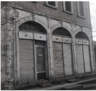
Εικόνα 46. Διαμόρφωση γωνιών με λαξευτούς λίθους και λίθινα χαμηλωμένα τόξα.
