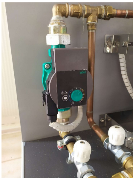
Εικόνα 3.40: Σύνδεση κυκλοφορητή στο υδραυλικό κύκλωμα
