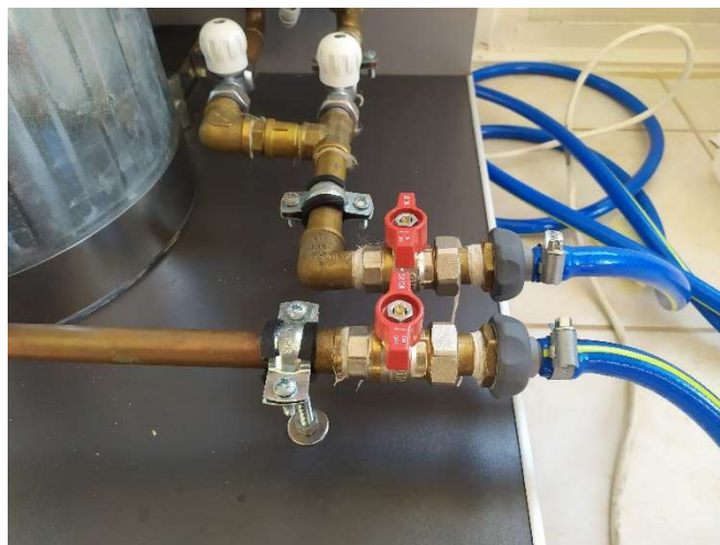
Εικόνα 3.37: Σφαιρικοί διακόπτες ροής νερού
