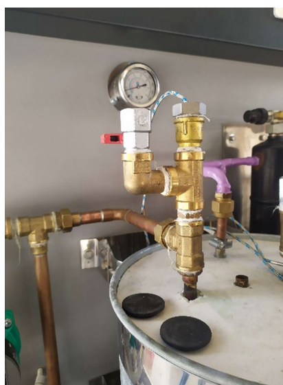
Εικόνα 3.10: Σύνδεση δοχείων εναλλακτών με το ψυκτικό και το υδραυλικό κύκλωμα
