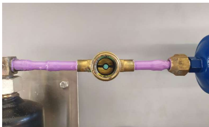
Εικόνα 3.16: Σύνδεση δείκτη υγρού - υγρασίας
