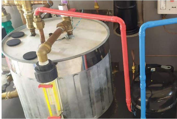
Εικόνα 3.24: Χρωματισμός γραμμής κατάθλιψης
