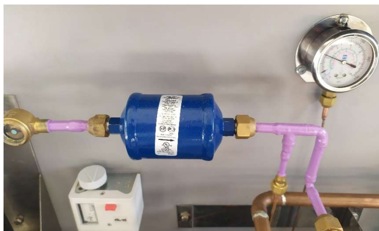
Εικόνα 3.18: Σύνδεση Φίλτρου - Ξηραντή στο ψυκτικό κύκλωμα
