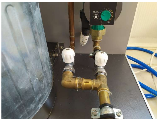
Εικόνα 3.41: Ρυθμιστικές βάνες παροχής νερού
