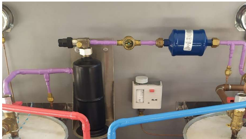
Εικόνα 3.25: Χρωματισμός γραμμής υγρού
