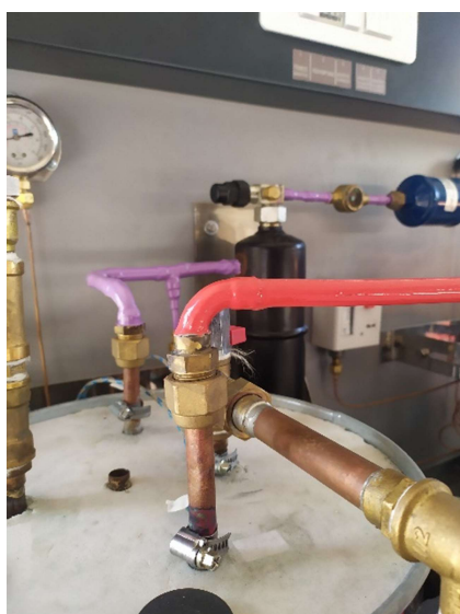
Εικόνα 3.10: Σύνδεση δοχείων εναλλακτών με το ψυκτικό και το υδραυλικό κύκλωμα
