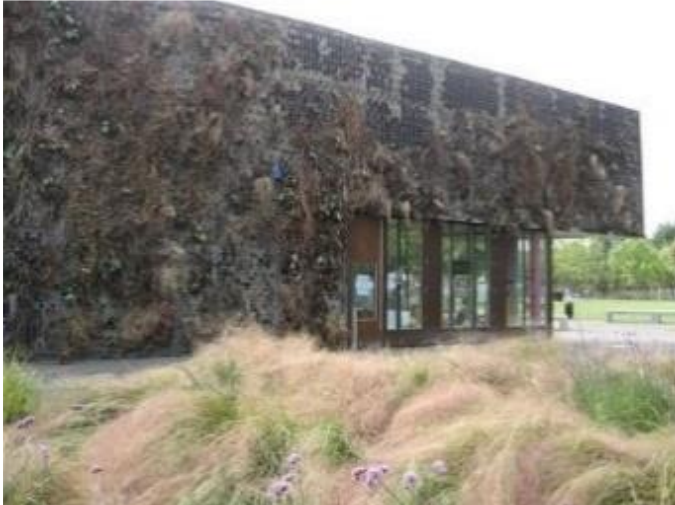
Εικόνα 38: Κατεστραμμένος πράσινος τοίχος με υδροπονικό σύστημα (Λονδίνο)
