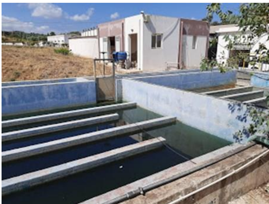
Εικόνα 2.4.1 Τυπική διάταξη δεξαμενής χλωρίωσης [ΕΕΛ Πλατανιά, 2020].
