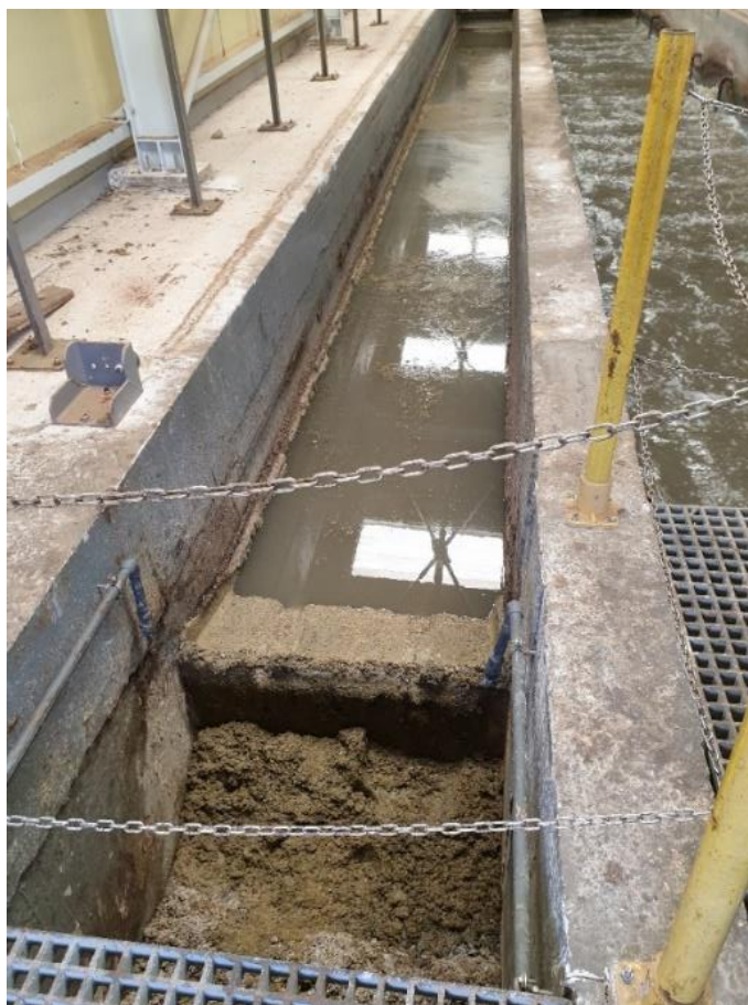
Εικόνα 3.1.1 Τυπική διάταξη εξάμμωσης – σπιβάδας απολίπανσης – φρεατίου συλλογής λιπών [ΕΕΛ Χανίων, 2021].
