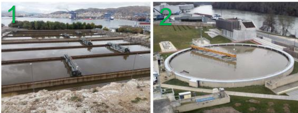
Εικόνα 2.2.1 Τυπικές διατάξεις δεξαμενών πρωτοβάθμιας καθίζησης (1. Ορθογωνικής διατομής, 2. Κυκλικής διατομής) [Γκίκας, 2020].
