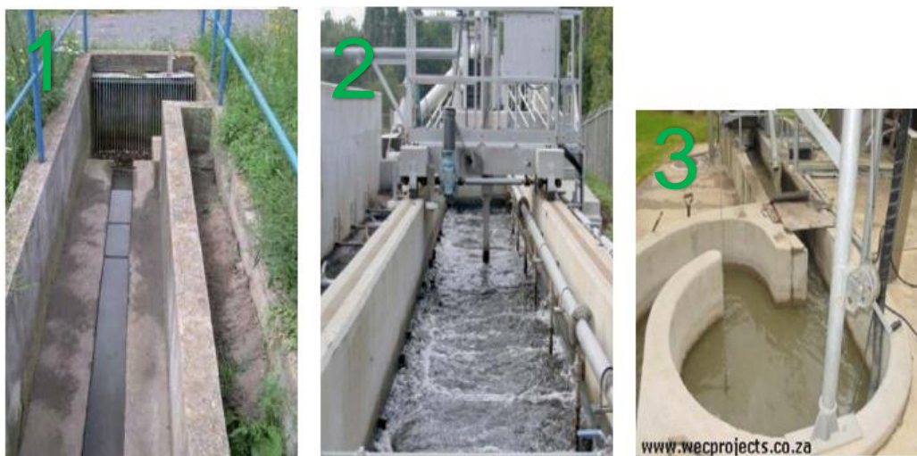
Εικόνα 2.1.2 Τυπικές διατάξεις εξαμμωτών (1. Σταθερής ροής, 2. Αεριζόμενος, 3. Κυκλωνοειδούς ροής) [Γκίκας, 2020].
