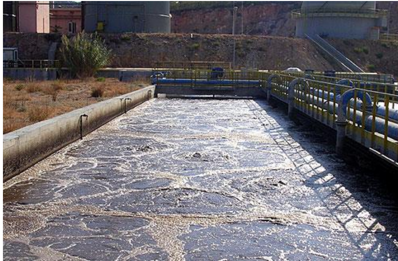
Εικόνα 2.3.1 Τυπική διάταξη δεξαμενής αερισμού [ΕΕΛ Χανίων, 2009].
