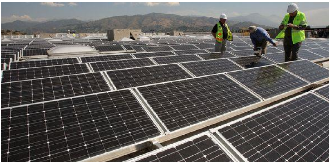
Εικόνα 3.2: Εγκατάσταση φωτοβολταϊκών επί στέγης σε ξενοδοχειακή μονάδα [72]
