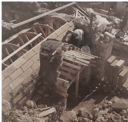
71 | Τεχνίτες κατασκευάζουν θόλο (2001)
