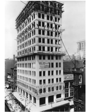
Εικόνα 3: Κατασκευή του Ingalls Building (1903), του πρώτου ουρανοξύστη από οπλισμένο σκυρόδεμα
