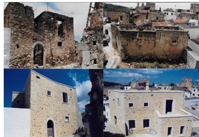
Εικόνα 16 Μαρουλάς (1997), Αποκατάσταση όψεων και παραθύρων, αρχείο Κ. Κορρέ
