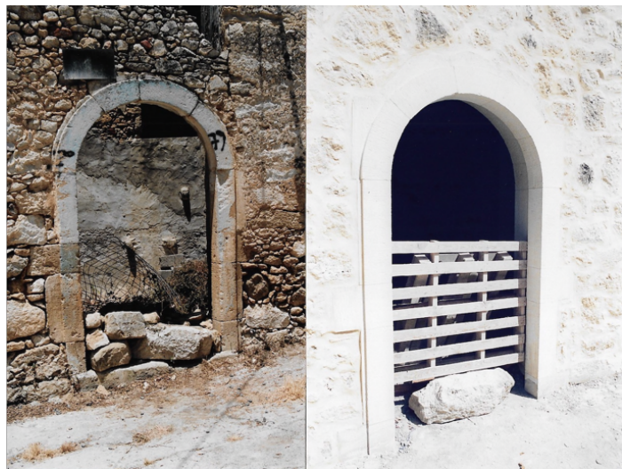
Εικόνα 17 Μαρουλάς (1997), Αποκατάσταση όψεων και παραθύρων, αρχείο Κ. Κορρέ
