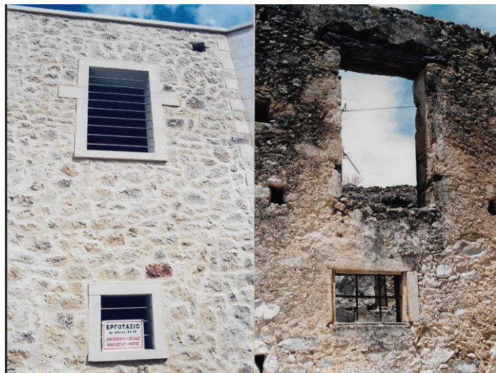
Εικόνα 18 Μαρουλάς (1997), Αποκατάσταση όψεων και παραθύρων, αρχείο Κ. Κορρέ
