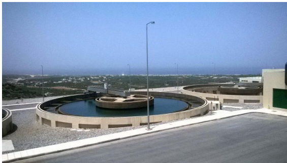
Εικόνα 5: Δεξαμενές Κροκίδωσης - Καθίζησης του νερού[5]
