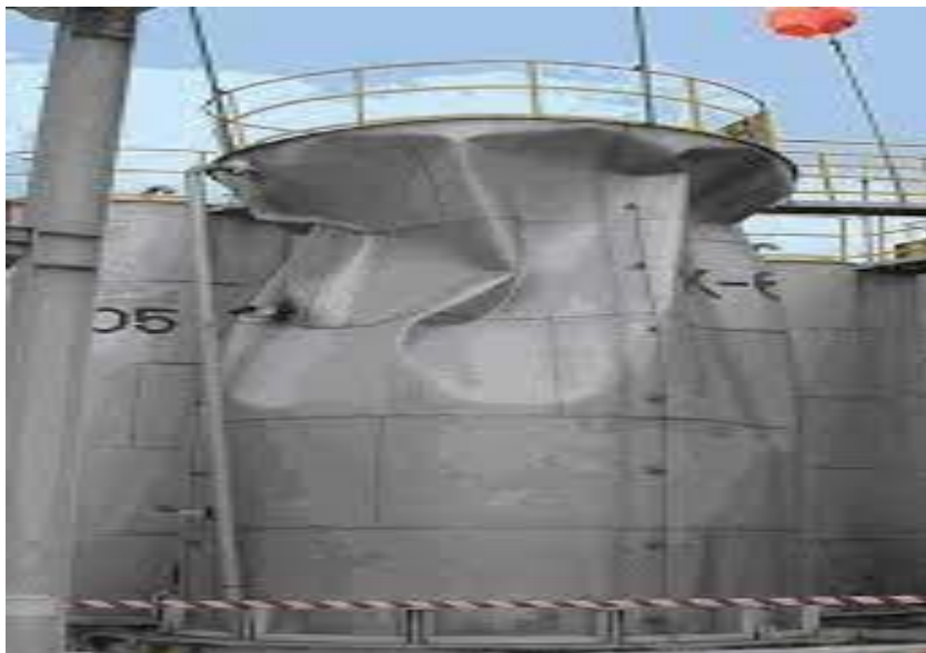
Εικόνα 13: Καταστροφή δεξαμενής λόγω υποπίεσης
