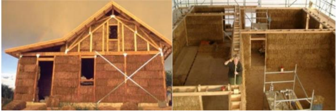
Figure 2.2: Παράδειγμα κατασκευής αχυρόμπαλων με ξύλινο σκελετό (Drozd et al., 2019)
