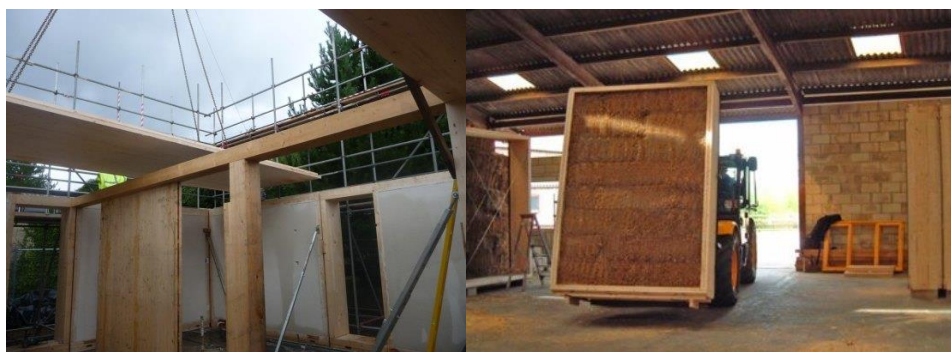
Figure 2.6 A and B: (A) Στάδιο κατασκευής BaleHaus (B) Πάνελ τοιχοποιίας BaleHaus (Meinhold, 2010)
