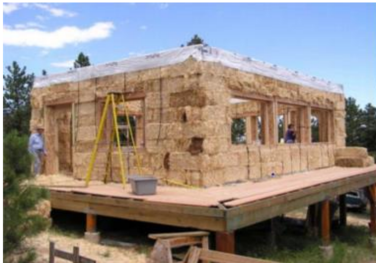
Figure 2.1: Παράδειγμα κατασκευής με δέματα άχυρου να παραλαμβάνουν το φορτίο (Drozd et al., 2019)
