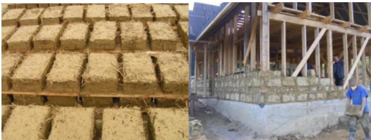
Figure 2.3: Δεμάτια ελαφρού πηλού και μέθοδος τοποθέτησης τους (Drozd et al., 2019)
