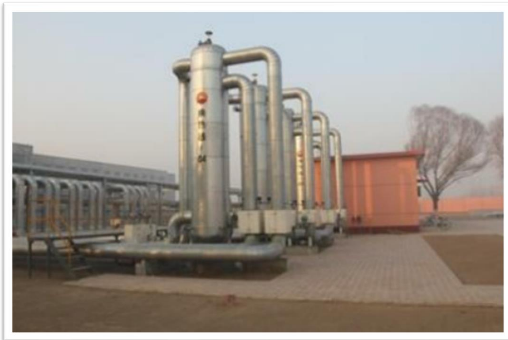
Εικόνα 2.3: Εναλλάκτης θερμότητας σε εργοστάσιο γεωθερμίας [17]
