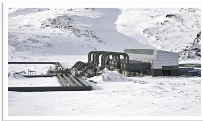
Εικόνα 4.21: Σταθμός διαχωριστή ατμού/νερού στο Hellisheidi [48]
