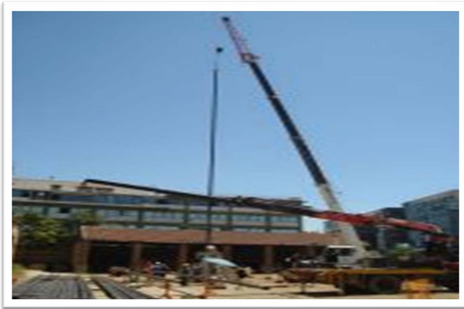
Εικόνα 4.3: Εγκατάσταση ομοαξονικού γεωεναλλάκτη θερμότητας [40]
