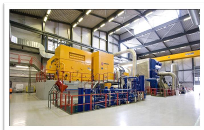
Εικόνα 4.22: Υποσύστημα ατμοστροβίλου υψηλής πίεσης στο Hellisheidi [48]
