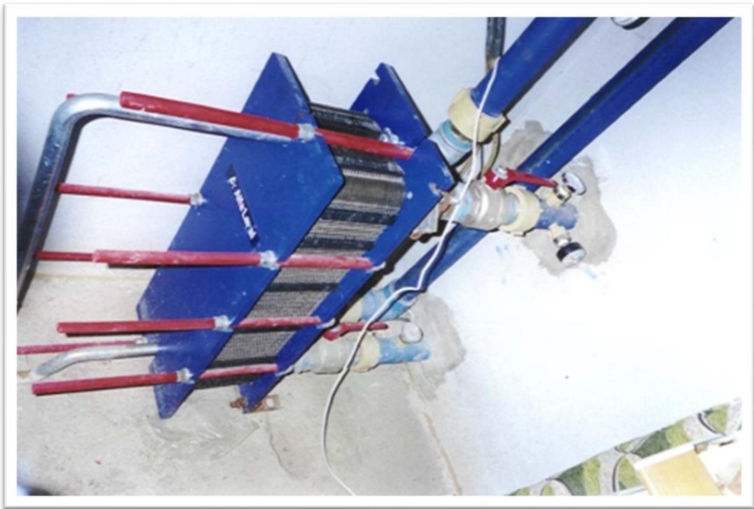
Εικόνα 4.6: Κεντρικός εναλλάκτης θερμότητας του ξενώνα [41]
