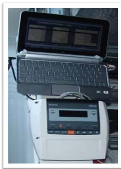
Εικόνα 4.11: Σύστημα απομακρυσμένου ελέγχου γεωθερμικών αντλιών θερμότητας [43]
