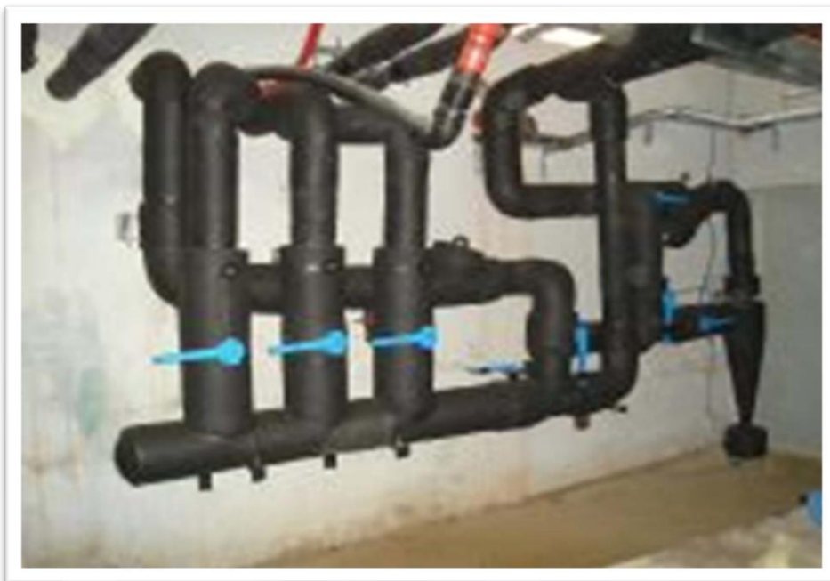
Εικόνα 4.4: Σύστημα σωληνώσεων από το μηχανοστάσιο του κτιρίου της Περιφέρειας Κεντρικής Μακεδονίας [40]
