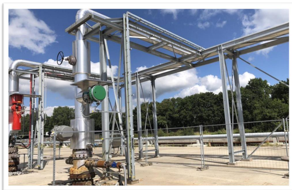
Εικόνα 2.7: Πηγάδια παραγωγής και έγχυσης σε γεωθερμικό σταθμό ηλεκτροπαραγωγής [25]
