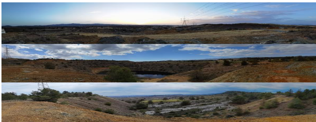
Εικόνα 2.9: Βόρειο Μεταλλείο Μαθιάτη από διαφορετική οπτική γωνία, από τις οποίες φαίνεται η προϋπάρχουσα εκμετάλλευση μεικτών θειούχων ορυκτών και οι σωροί στείρου υλικού.
